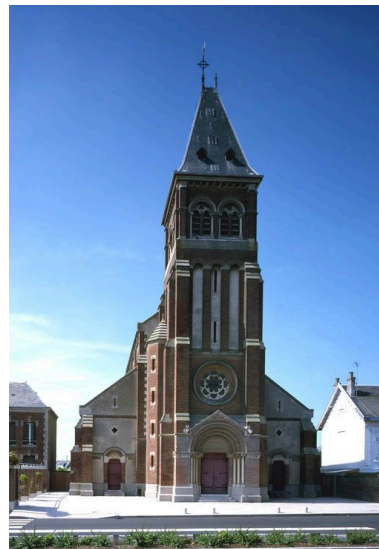
Élévation antérieure. Phot. Marie-Laure Monnehay-Vulliet IVR22_20048000136VA
