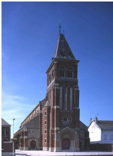
Vue d'ensemble. Phot. Marie-Laure Monnehay-Vulliet IVR22_20048000137VA
