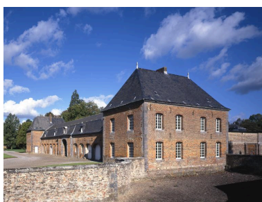
L'aile orientale des communs. Phot. Thierry Lefébure IVR22_19950202952VA
