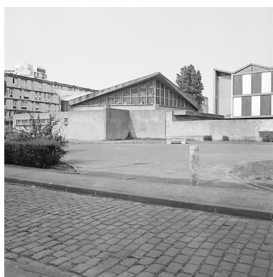
Vue d'angle sud en 1995. Phot. Philippe Dapvril IVR31_19956200578X
