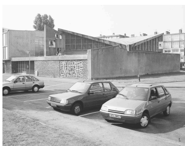
Vue d' angle nord en 1995. Phot. Philippe Dapvril IVR31_19956200575X
