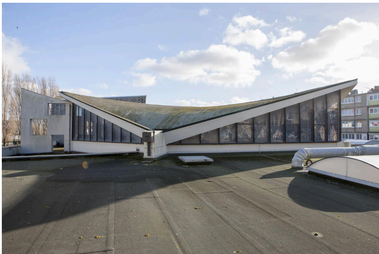
Vue des verrières depuis le toit de l'extension.
