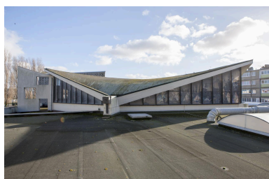
Vue des verrières depuis le toit de l'extension. Phot. Pierre Thibaut IVR31_20156200007NUCA
