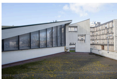
Vue de l'ancien clocher. Phot. Pierre Thibaut IVR31_20156200006NUCA
