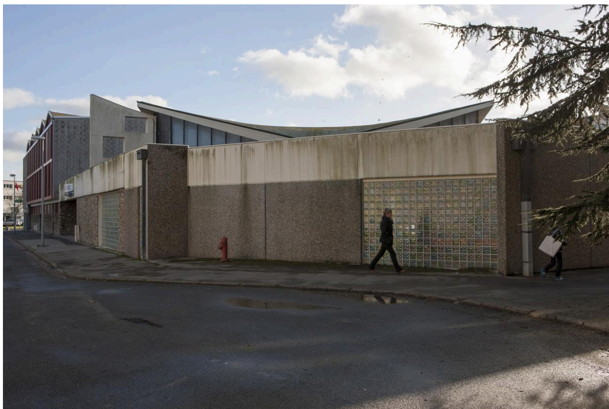
Vue de l'extension nord-ouest.
