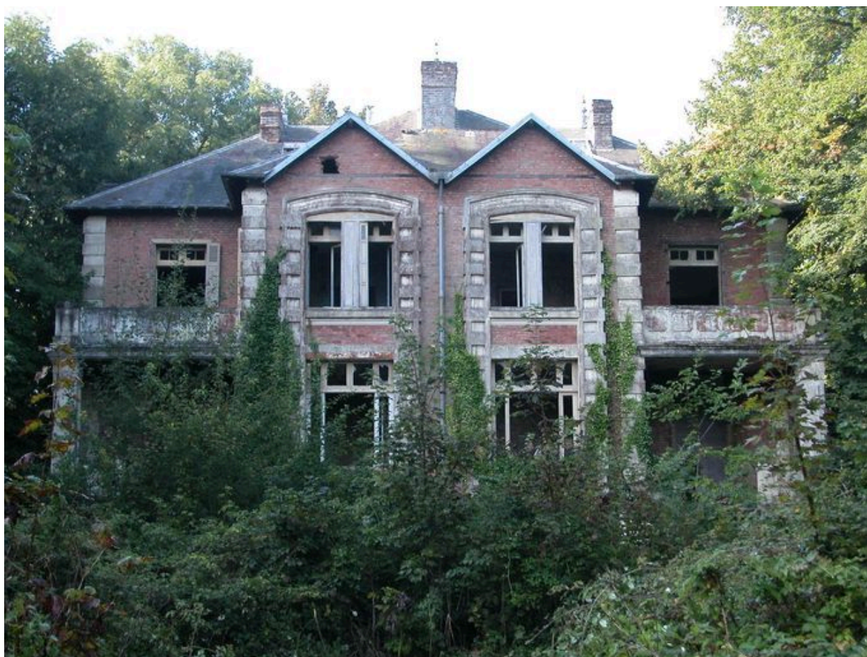
Maison, avenue Romain-Michel, détruite en cours d'étude.
