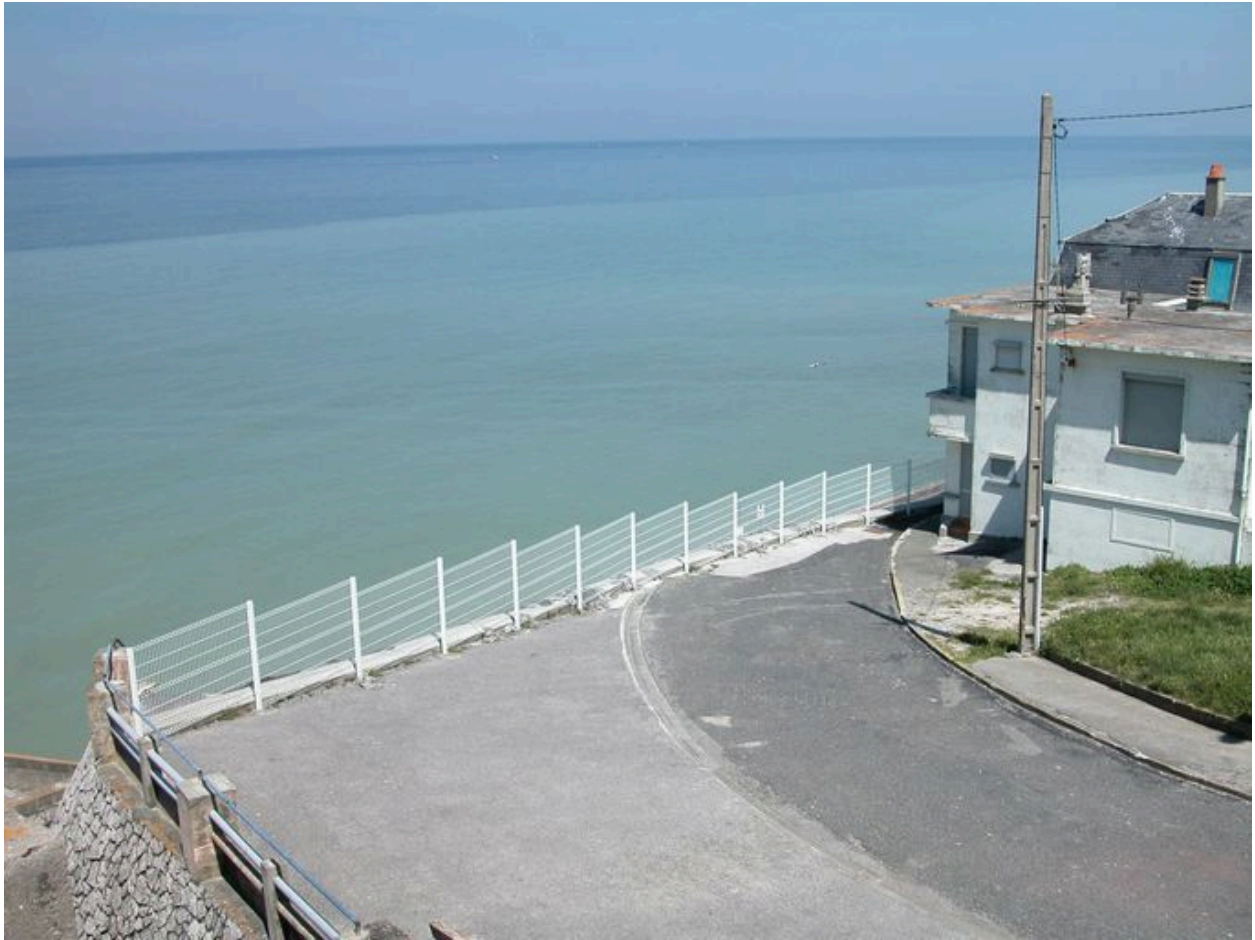
Le rétrécissement de la rue Jamart, état en 2005.
