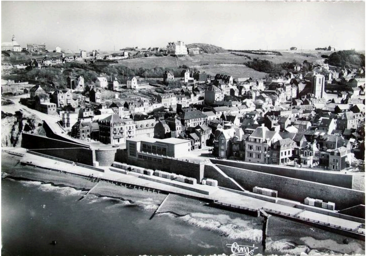
Le front de mer avec le dernier casino et le mur de soutènement de la falaise, carte postale, 2e moitié 20e siècle (coll. part.).
