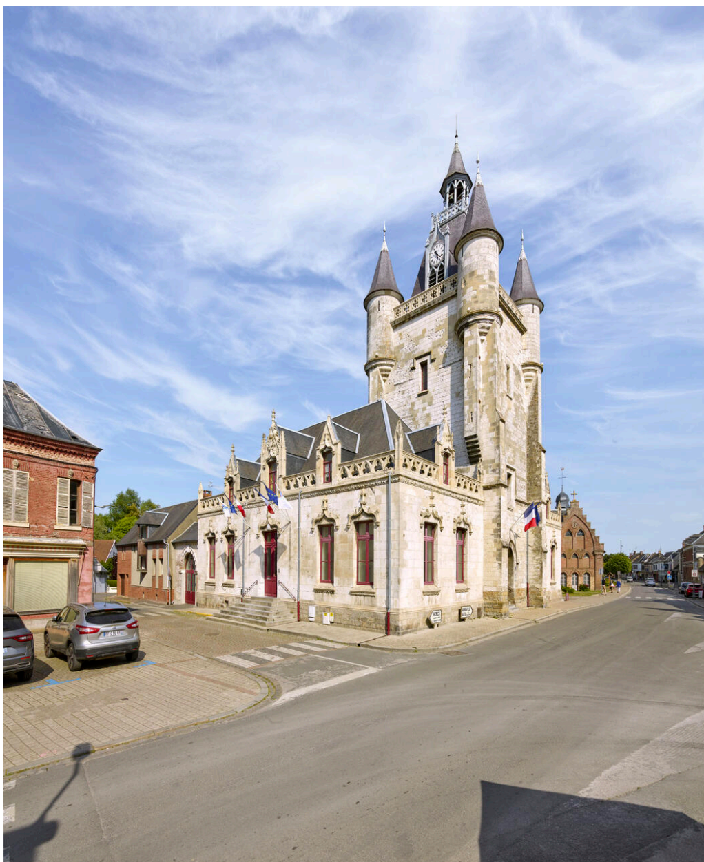
Vue d'ensemble sud-ouest du beffroi.
