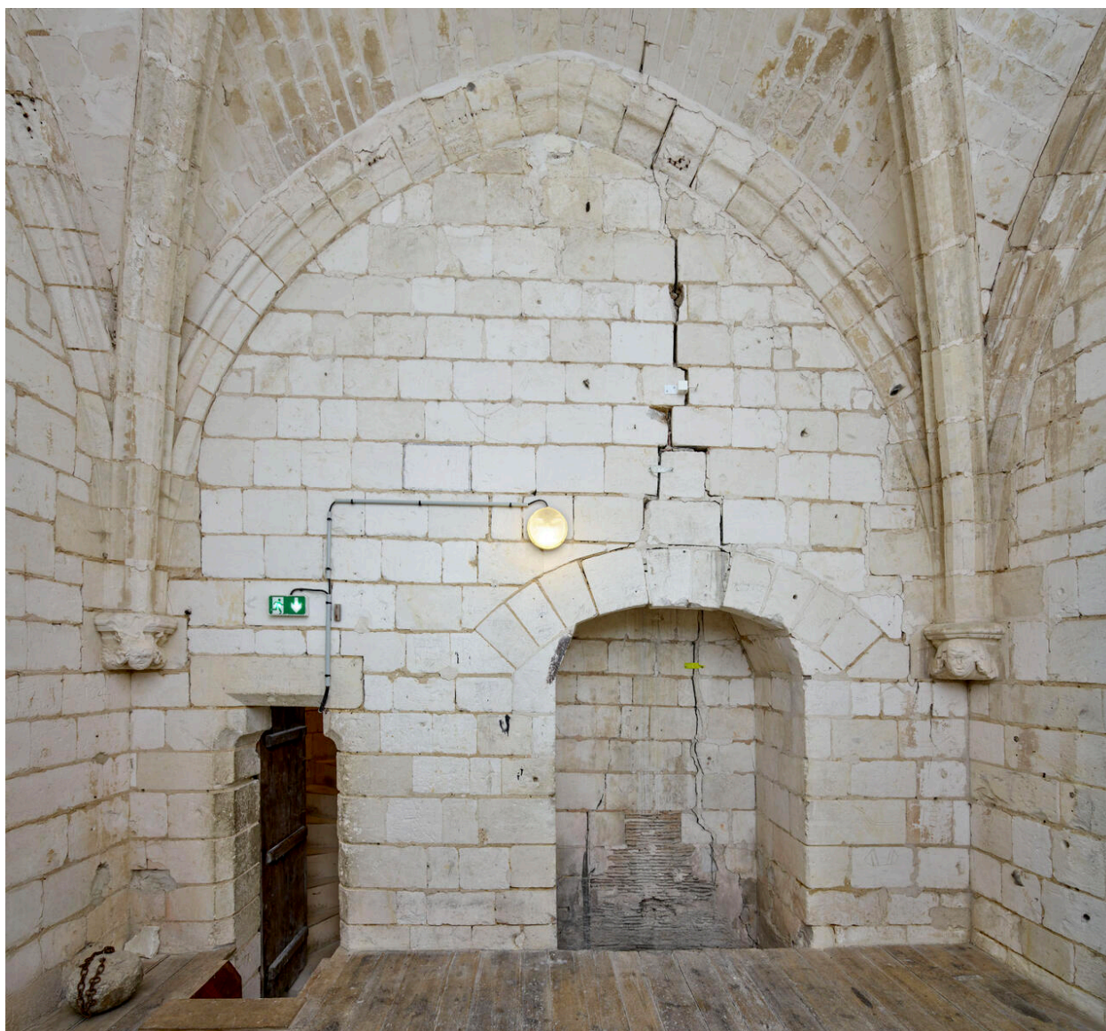
Intérieur de la salle des gardes du beffroi.
