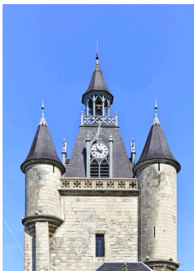
Détail de la couverture du beffroi et de ses tourelles. Phot. Thierry Lefébure IVR32_20258000820NUCA
