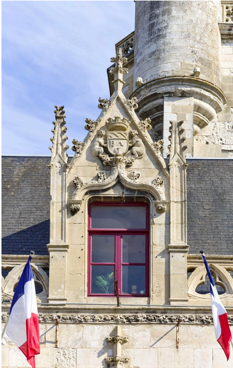
Détail de la lucarne néo-gothique portant les armes de la ville de Rue.
