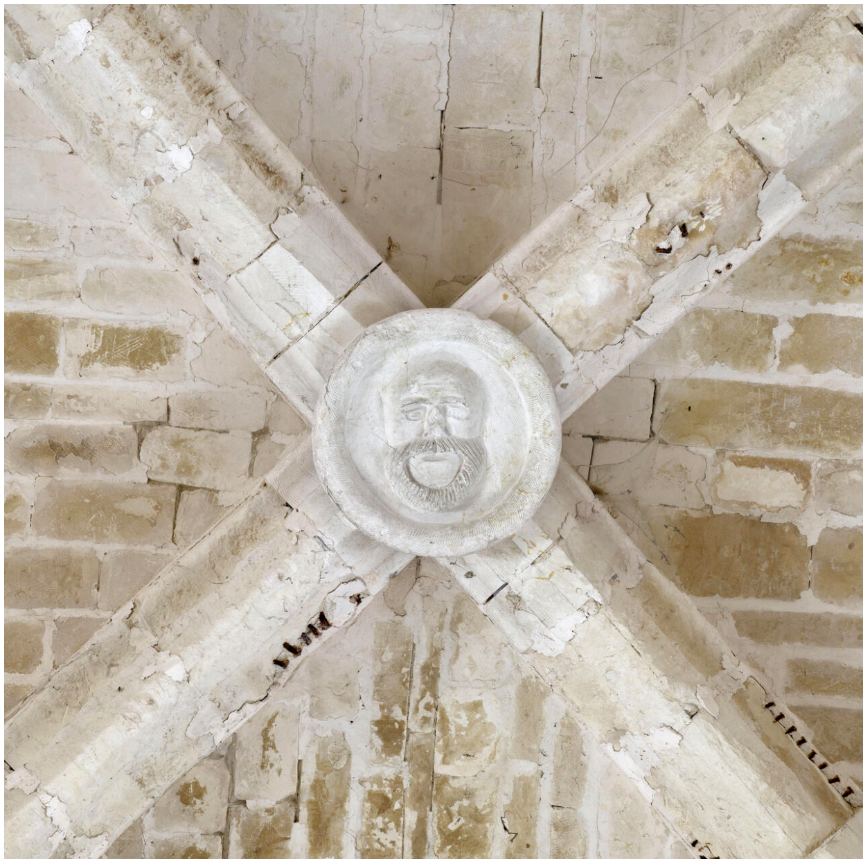
Clef de voûte sculptée de la salle des gardes.
