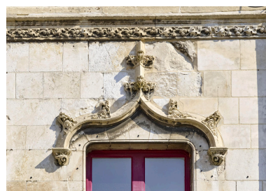
Détail du décor de la frise et d'un arc en accolade néo-gothique d'une des baies de la façade ouest. Phot. Thierry Lefébure IVR32_20258000814NUCA
