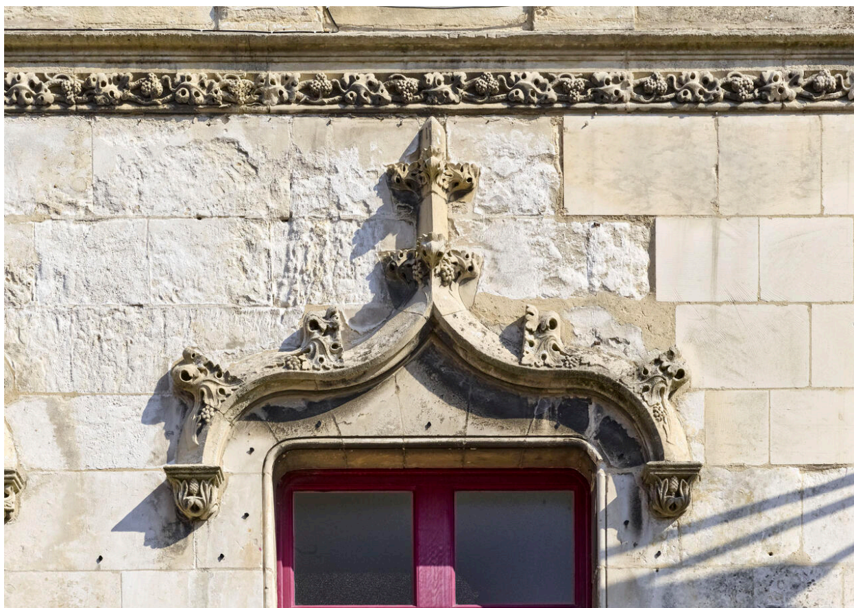
Détail de la frise ornée de ceps de vignes et d'un arc en accolade néo-gothique d'une des baies de la façade ouest.
