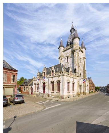
Vue d'ensemble sud-ouest du beffroi.
