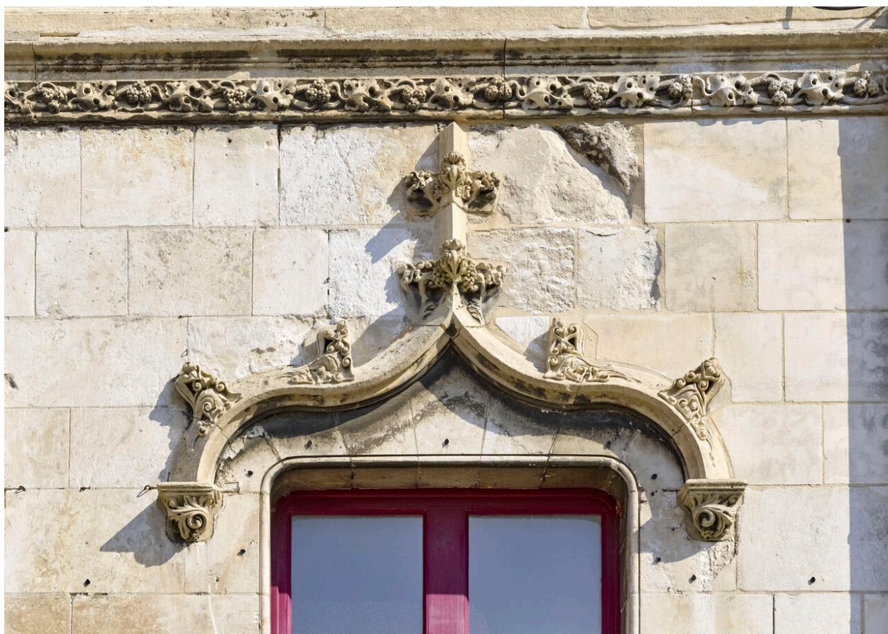
Détail du décor de la frise et d'un arc en accolade néo-gothique d'une des baies de la façade ouest.
