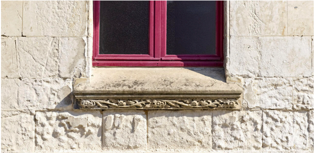
Détail du décor végétal néo-gothique de l'appui de fenêtre de la façade ouest du beffroi.
