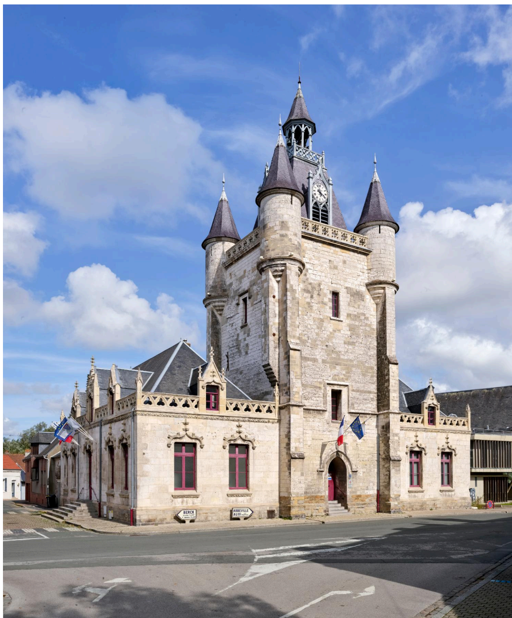
Vue d'ensemble sud-ouest du beffroi.
