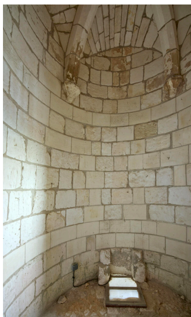
Vue intérieure du cachot attenant à la salle des gardes. Phot. Thierry Lefébure IVR32_20258000864NUCA
