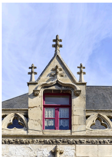
Détail d'une lucarne néo-gothique ornée d'un arc en accolade. Phot. Thierry Lefébure IVR32_20258000812NUCA
