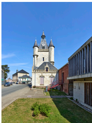
Vue d'ensemble, est du beffroi. Phot. Thierry Lefébure IVR32_20258000818NUCA
