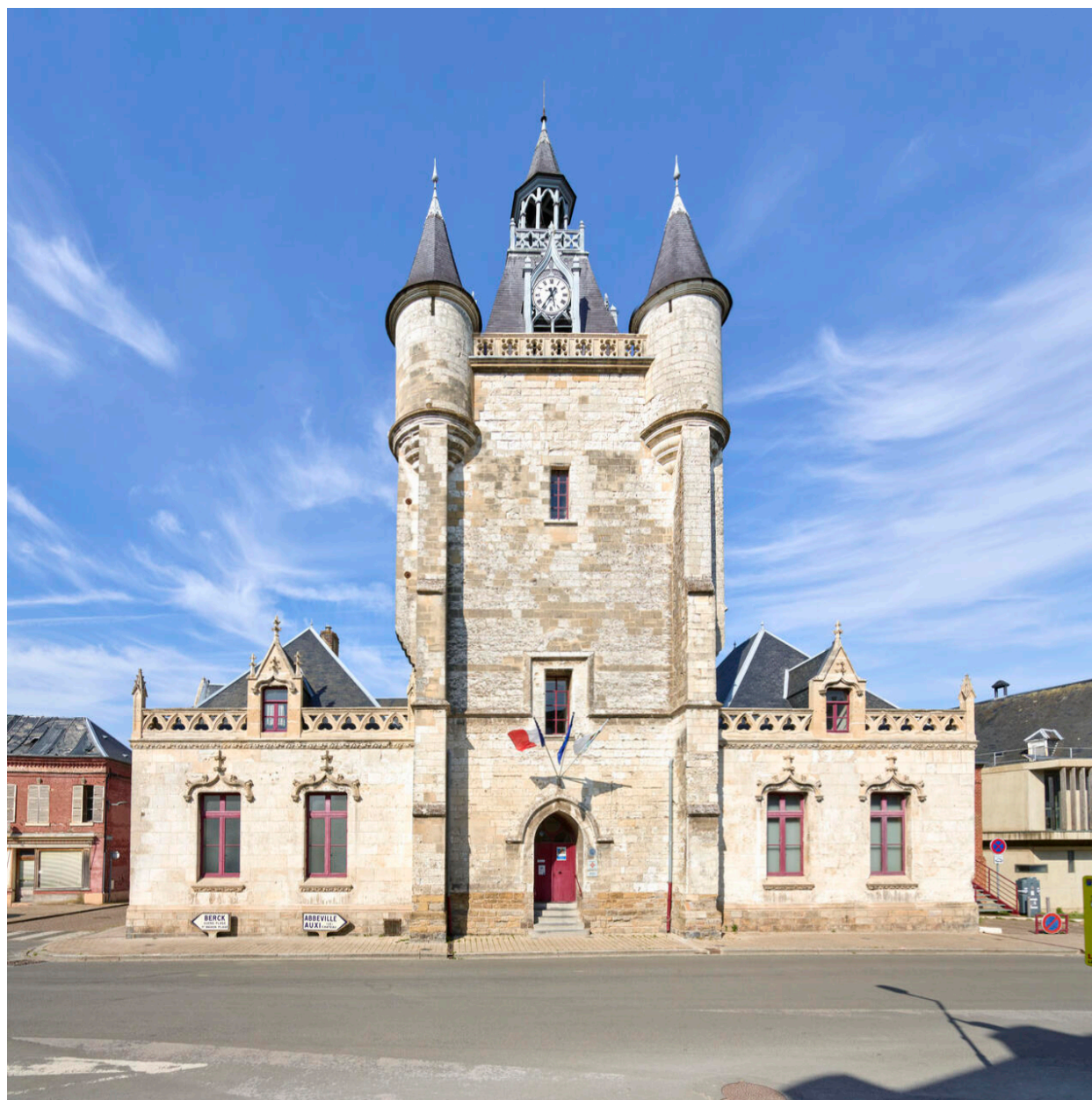
Vue d'ensemble, sud du beffroi.
