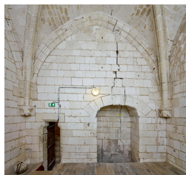
Intérieur de la salle des gardes du beffroi. Phot. Thierry Lefébure IVR32_20258000862NUCA
