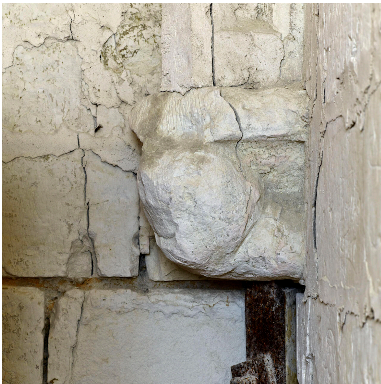
Détail d'un cul de lampe sculpté de la salle des gardes du beffroi.
