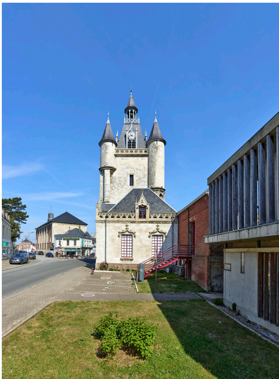
Vue d'ensemble, est du beffroi.
