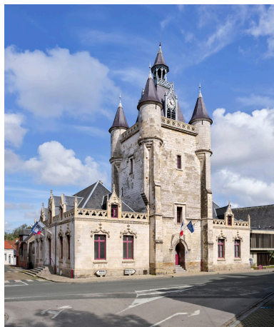
Vue d'ensemble sud-ouest du beffroi. Phot. Thierry Lefébure IVR32_20258000885NUCA
