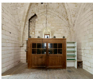
Armoire abritant le mécanisme des cloches du beffroi, dans la salle des gardes. Phot. Thierry Lefébure IVR32_20258000851NUCA
