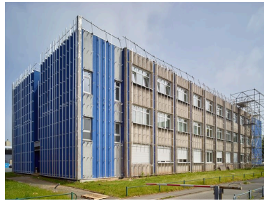
Le centre de formation depuis le nord-ouest, en cours de rénovation.
