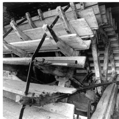
Détail de la roue hydraulique verticale.
