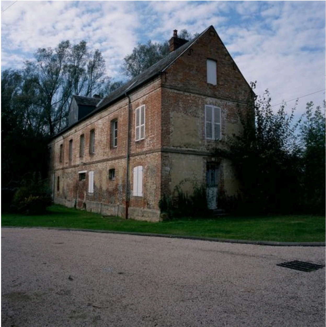
Vue d'ensemble de la façade est du moulin.
