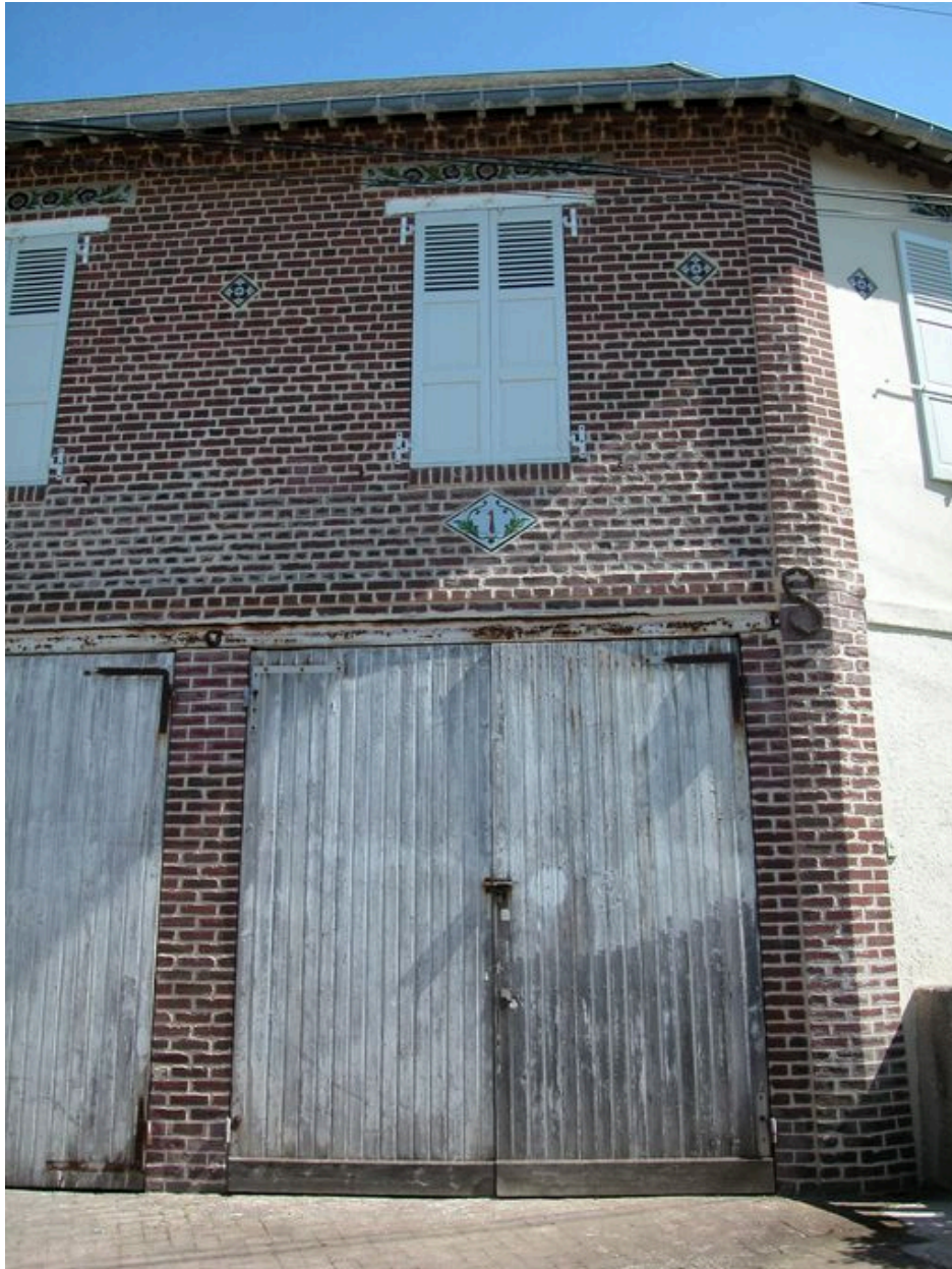
Détail d'une travée avec garage.
