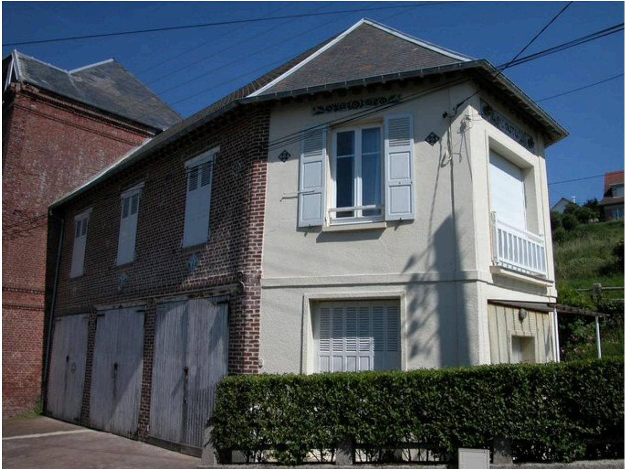
Vue d'ensemble depuis la rue Gros.
