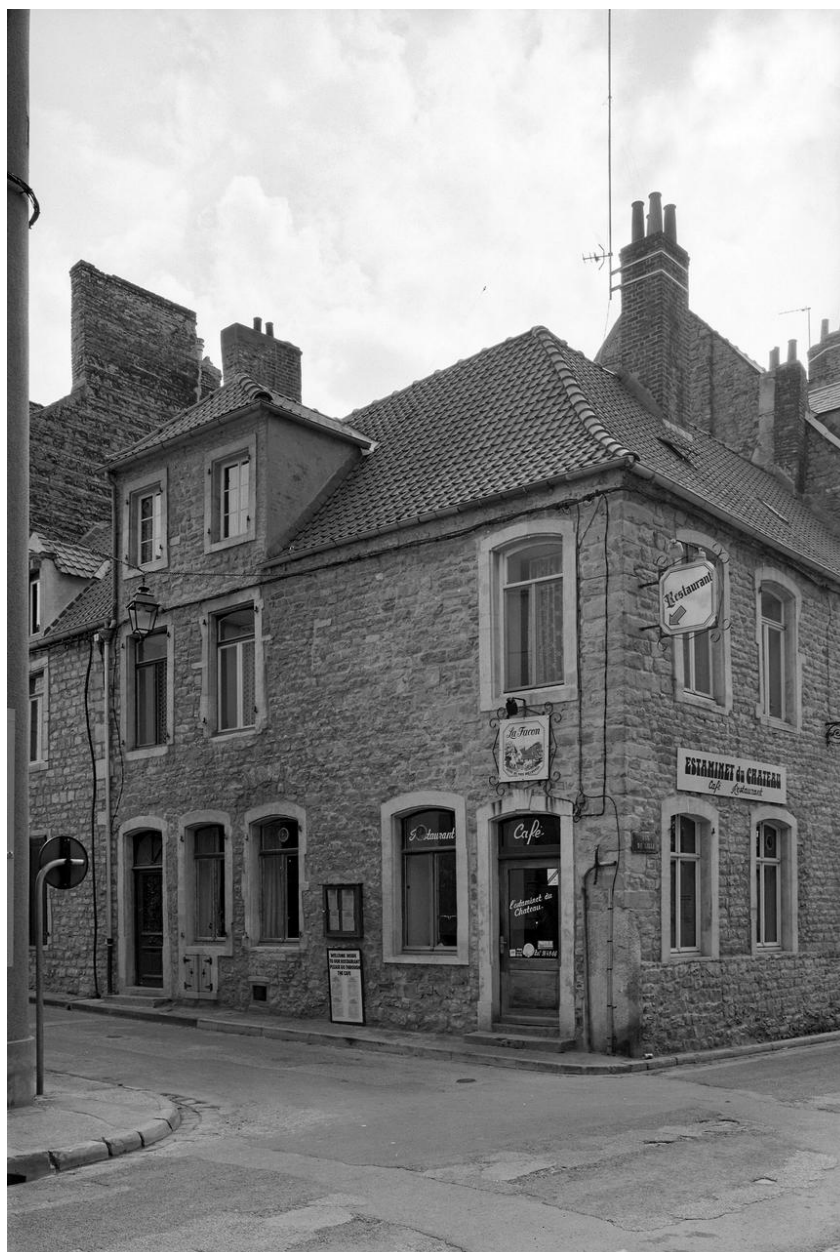
Vue générale après restauration.
