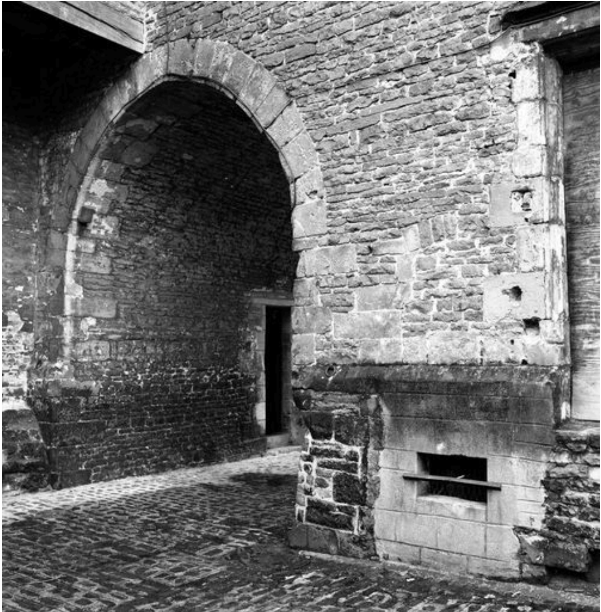
Corps de logis médiéval, façade arrière, rez-de-chaussée, vue partielle : débouché du passage couvert et, au premier plan, emplacement de l'accès d'origine à la cave.
