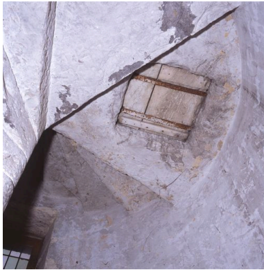
Corps de logis médiéval, intérieur, tourelle d'escalier (ouest), montée entre le 1er et le 2e étage : trappe fermant la trémie. Phot. Pierre Thibaut IVR31_20085900680XA
