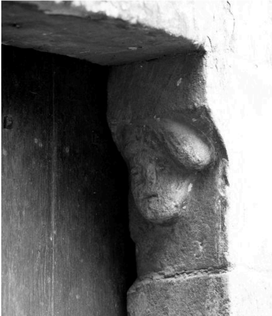
Corps de logis médiéval, façade arrière, tourelle d'escalier (ouest), rez-de-chaussée, porte d'accès, détail : tête masculine sculptée sur le coussinet portant le linteau.
