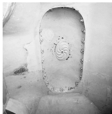
Aile de la rue de la Cavalerie : n° 35-37, cage de l'escalier "de Louis XIV" desservant actuellement le 1er étage du corps de logis médiéval, plafond.
