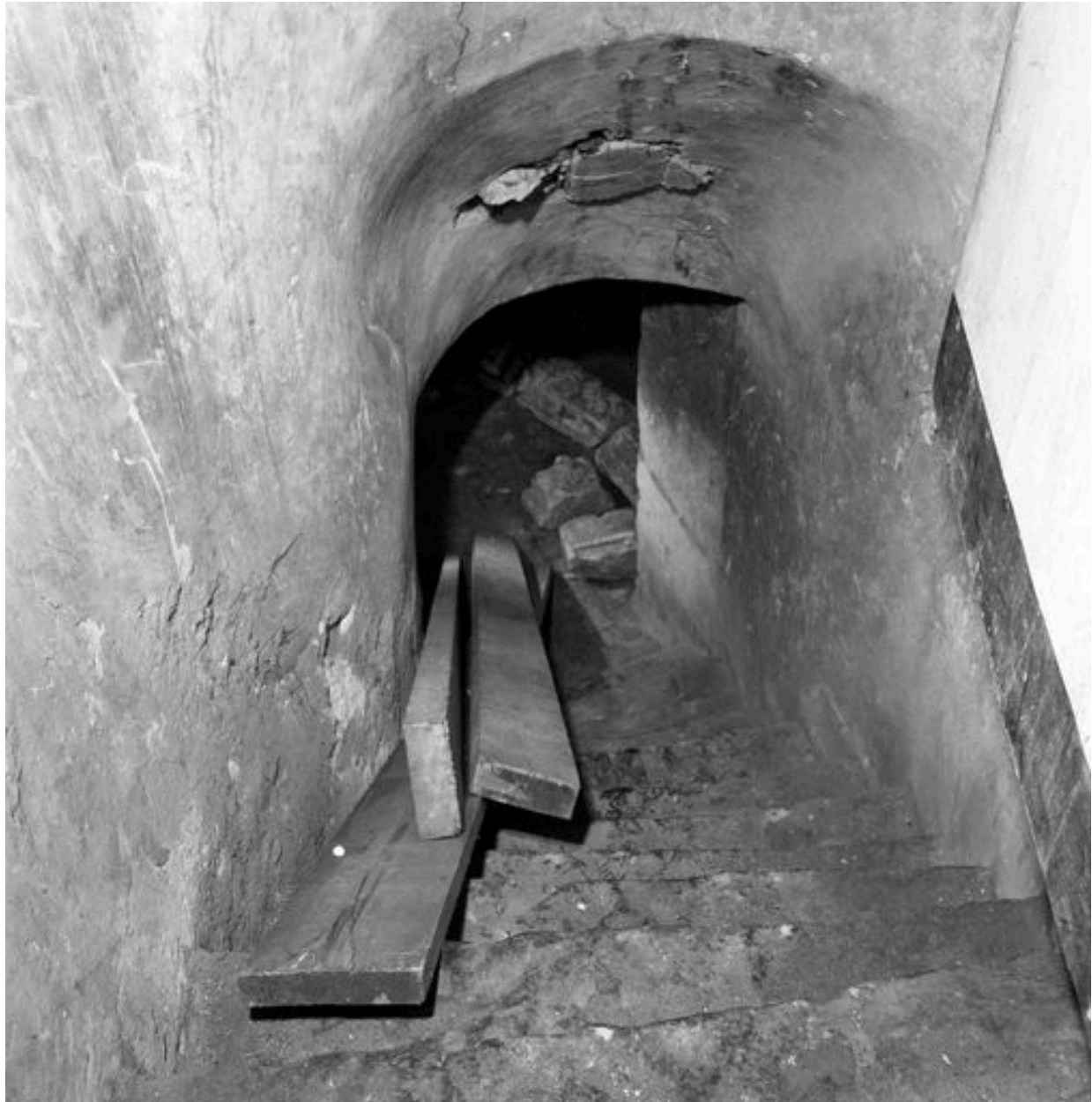
Corps de logis médiéval, intérieur, cave, escalier d'accès aménagé depuis le rez-de-chaussée de l'aile n° 35-37 rue de la Cavalerie : vue depuis le haut de l'escalier.
