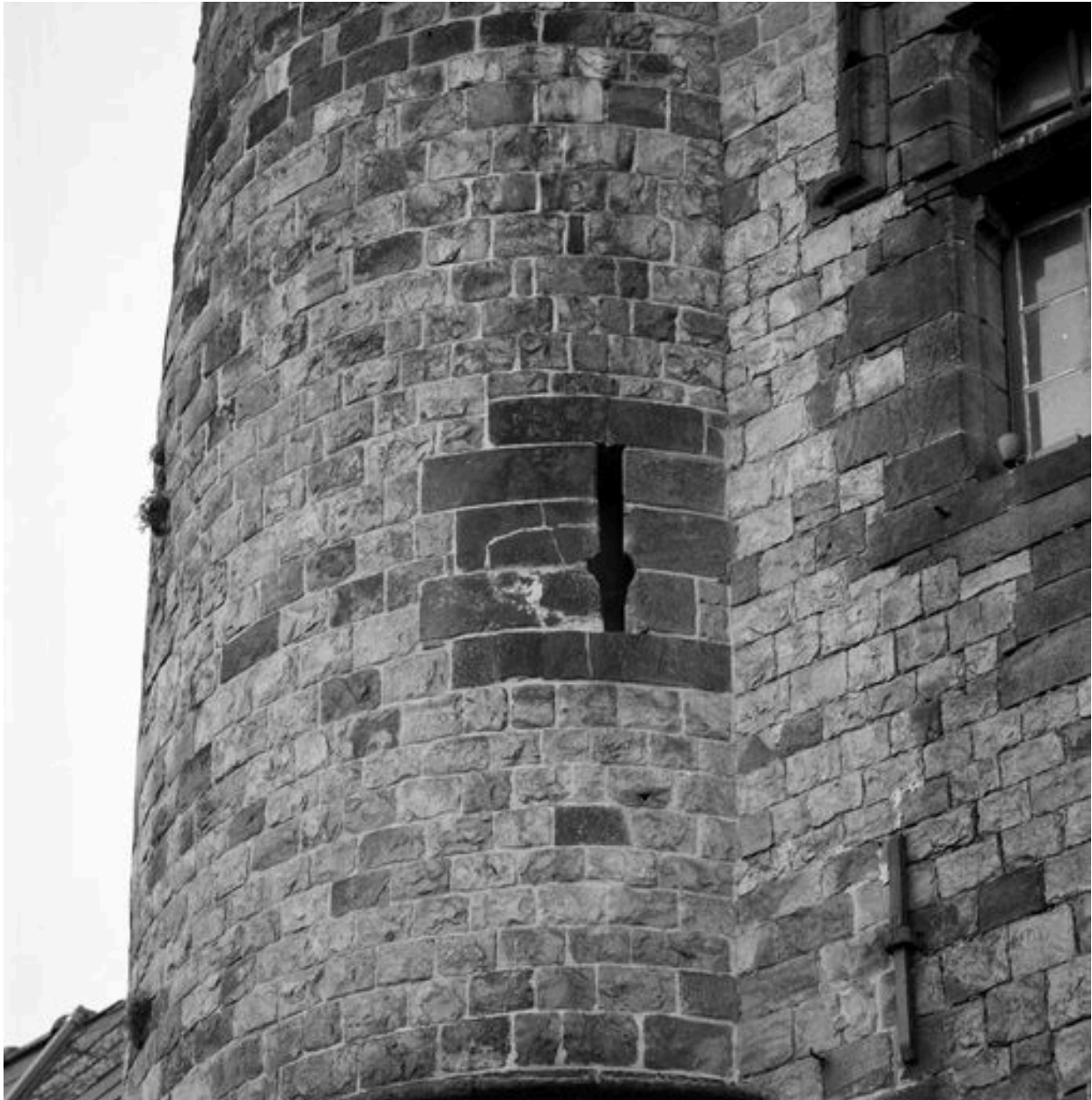
Corps de logis médiéval, façade, tourelle sud, 2e étage : archère.
