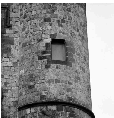
Corps de logis médiéval, façade, tourelle est, 2e étage : baie
