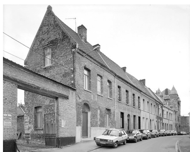
Aile de la rue de la Cavalerie : vue en enfilade du n° 27 vers le n° 37, état en 2001. Phot. Pierre Thibaut IVR31_20015900022V
