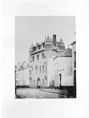
Château, vue générale depuis la place Verte, fin du 19e siècle (AD Nord). Repro. Pierre Thibaut IVR31_20005900666XB
