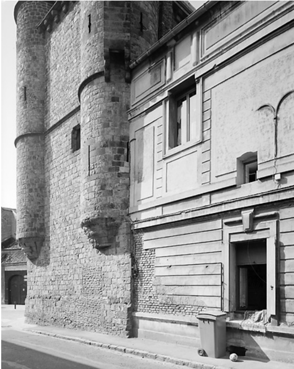
Corps de bâtiment médiéval et liaison avec l'aile sur la rue de la Bibliothèque : état en 2002.
