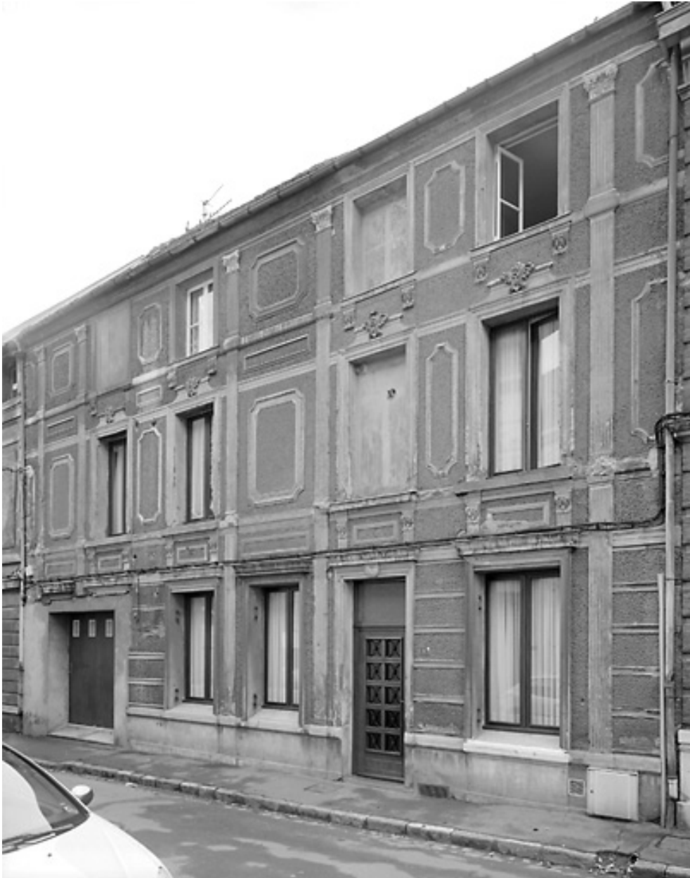
Aile de la rue de la Bibliothèque : vue partielle, n° 5, état en 2001.
