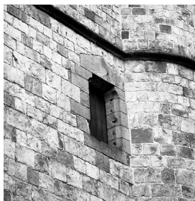
Corps de logis médiéval, façade en retour rue de la Bibliothèque, 1er étage, détail : baie couverte
