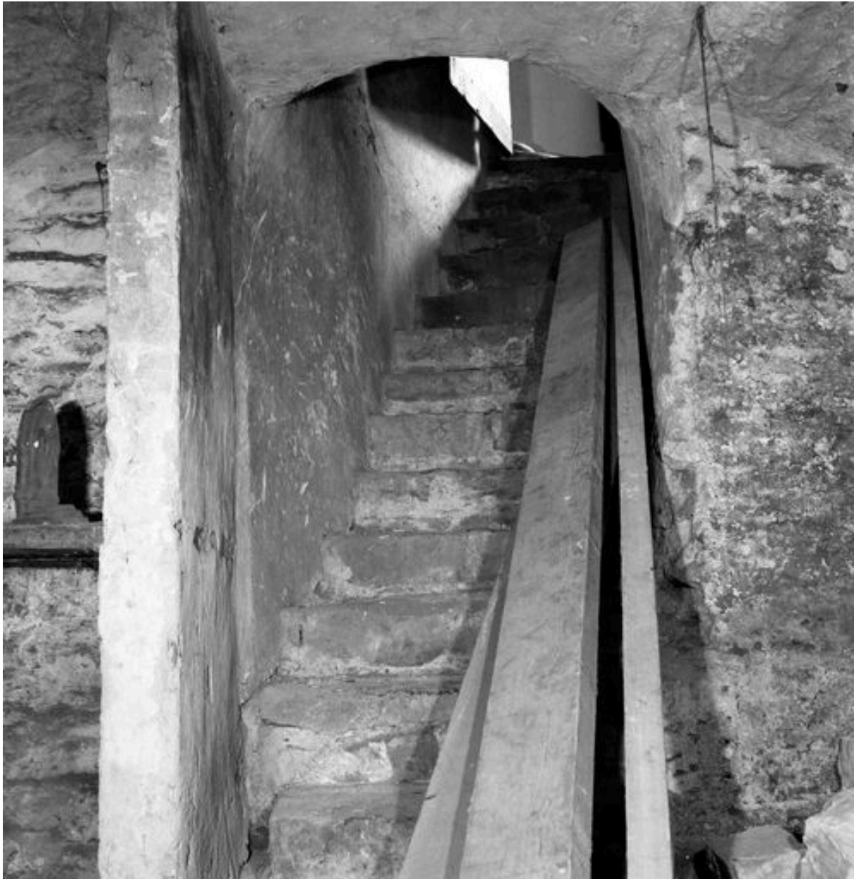
Corps de logis médiéval, intérieur, cave, escalier d'accès aménagé depuis le rez-de-chaussée de l'aile n° 35-37 rue de la Cavalerie : vue depuis la cave.
