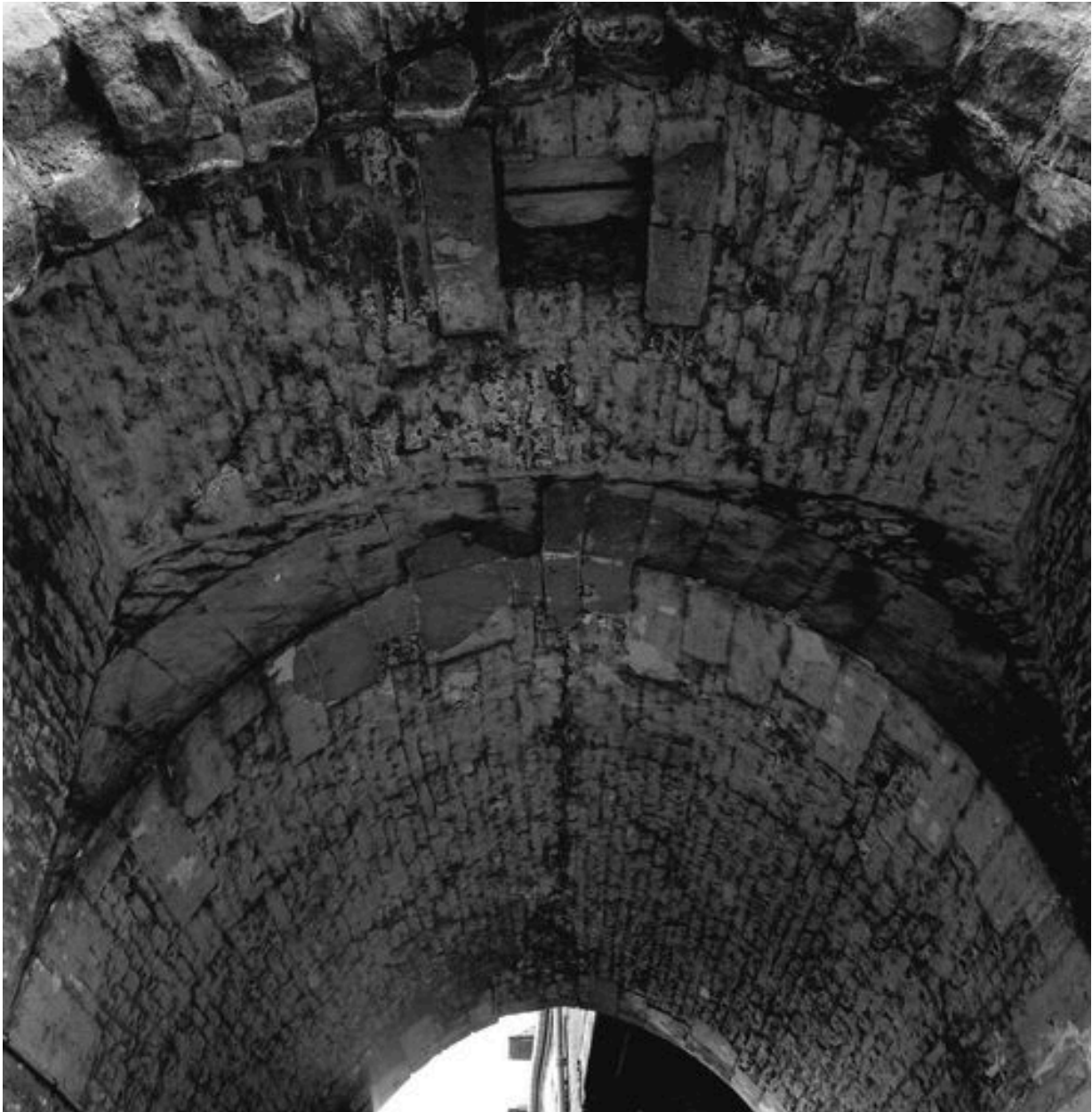
Corps de logis médiéval, passage couvert, vue depuis l'entrée : voûtement ; au premier plan, l'assomoir.
