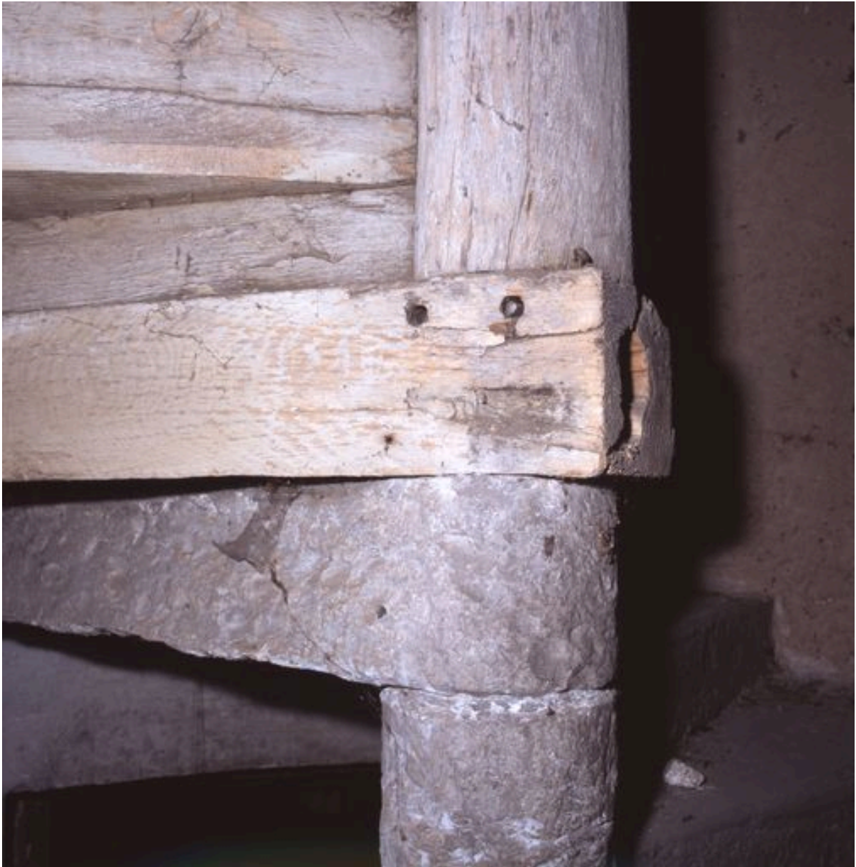
Corps de logis médiéval, intérieur, tourelle d'escalier (ouest), accès à l'étage de comble, détail : à la pierre marbrière succède le bois pour l'embranchement.
