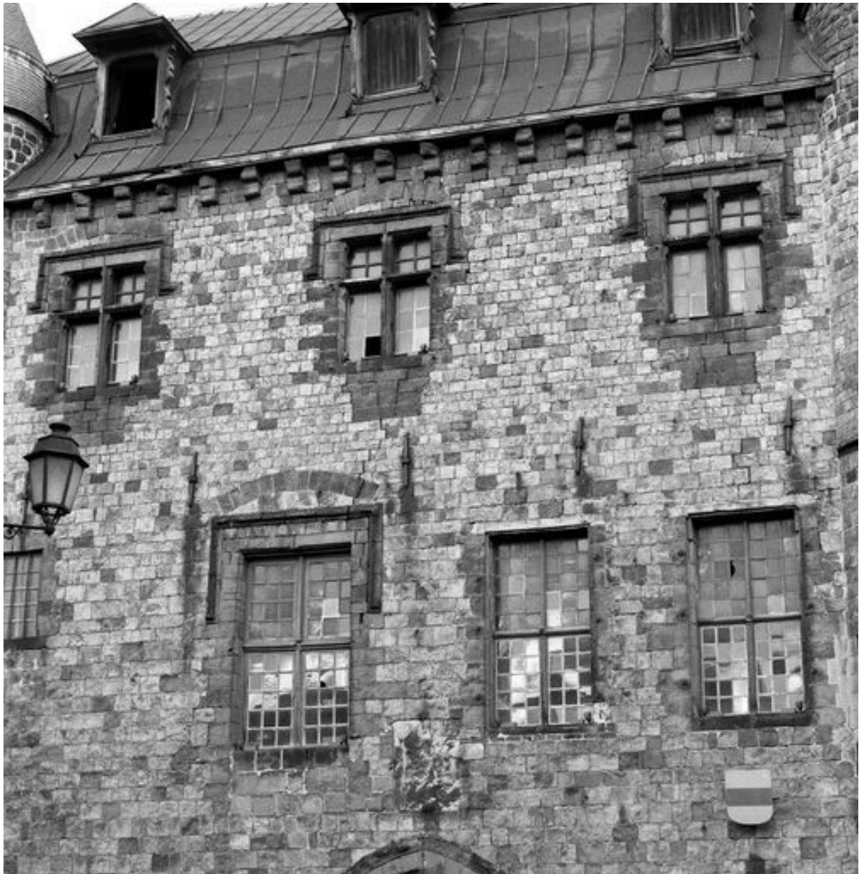
Corps de logis médiéval, façade, 1er et 2e étages, vue partielle : percements.
