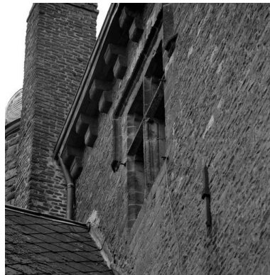
Corps de logis médiéval, façade arrière, travée nord-ouest, 2e étage, vue partielle : baie à croisée de pierre (grande salle), corbeaux de pierre. Phot. Pierre Thibaut IVR31_20085900757X
