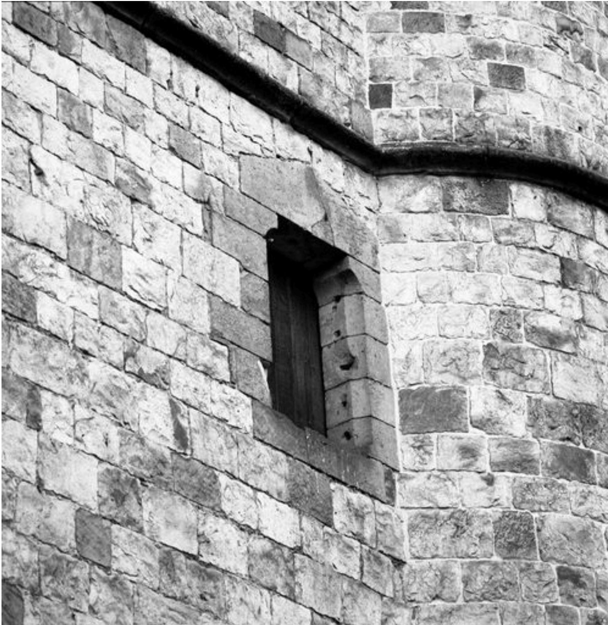
Corps de logis médiéval, façade en retour rue de la Bibliothèque, 1er étage, détail : baie couverte par un linteau en bâtière reposant sur des coussinets.
