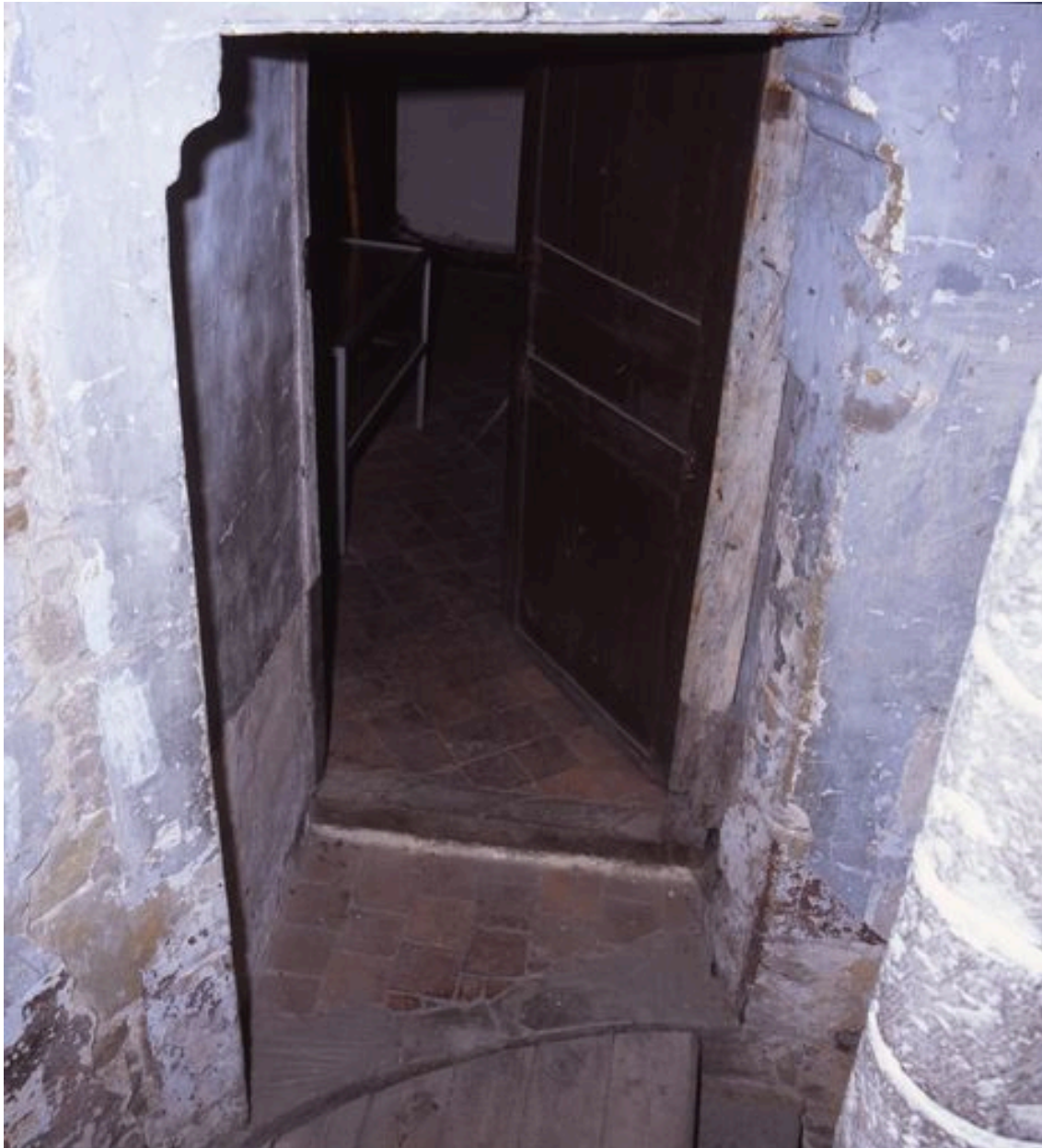
Corps de logis médiéval, intérieur, tourelle d'escalier (ouest), porte donnant accès à la montée entre le 1er et le 2e étage. Cette porte comporte un linteau reposant sur des coussinets.
