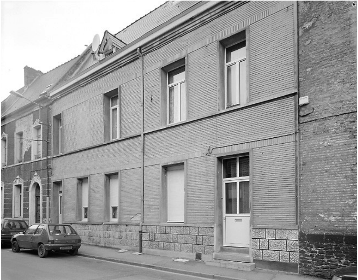
Aile de la rue de la Cavalerie : vue partielle, n° 35-37, état en 2001.
