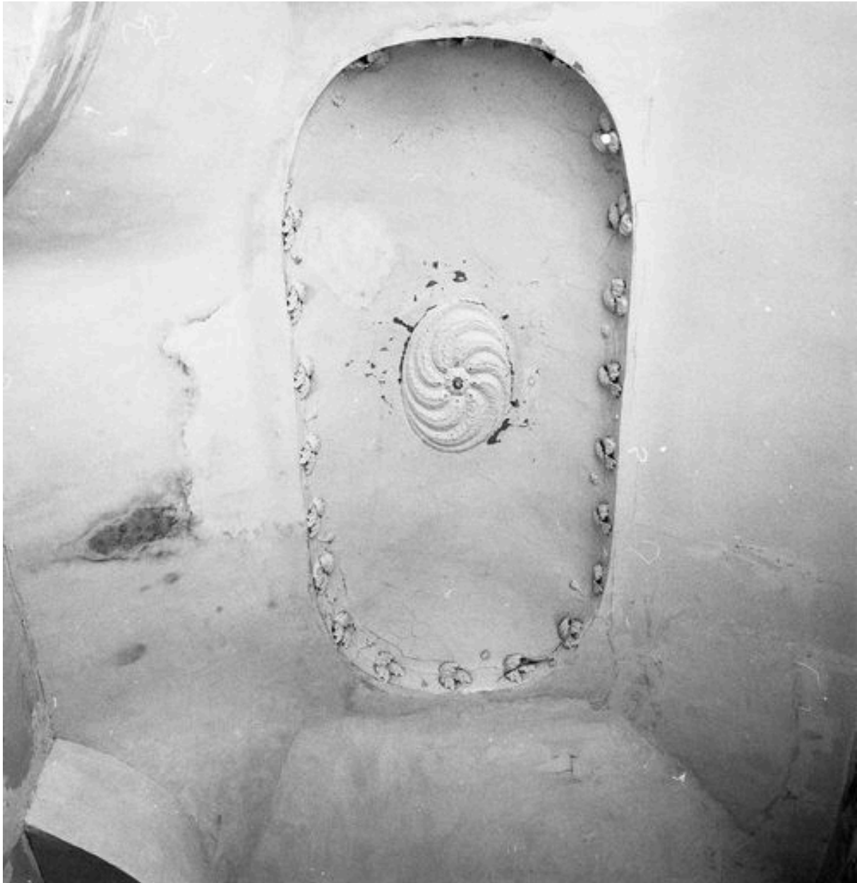
Aile de la rue de la Cavalerie : n° 35-37, cage de l'escalier "de Louis XIV" desservant actuellement le 1er étage du corps de logis médiéval, plafond.
