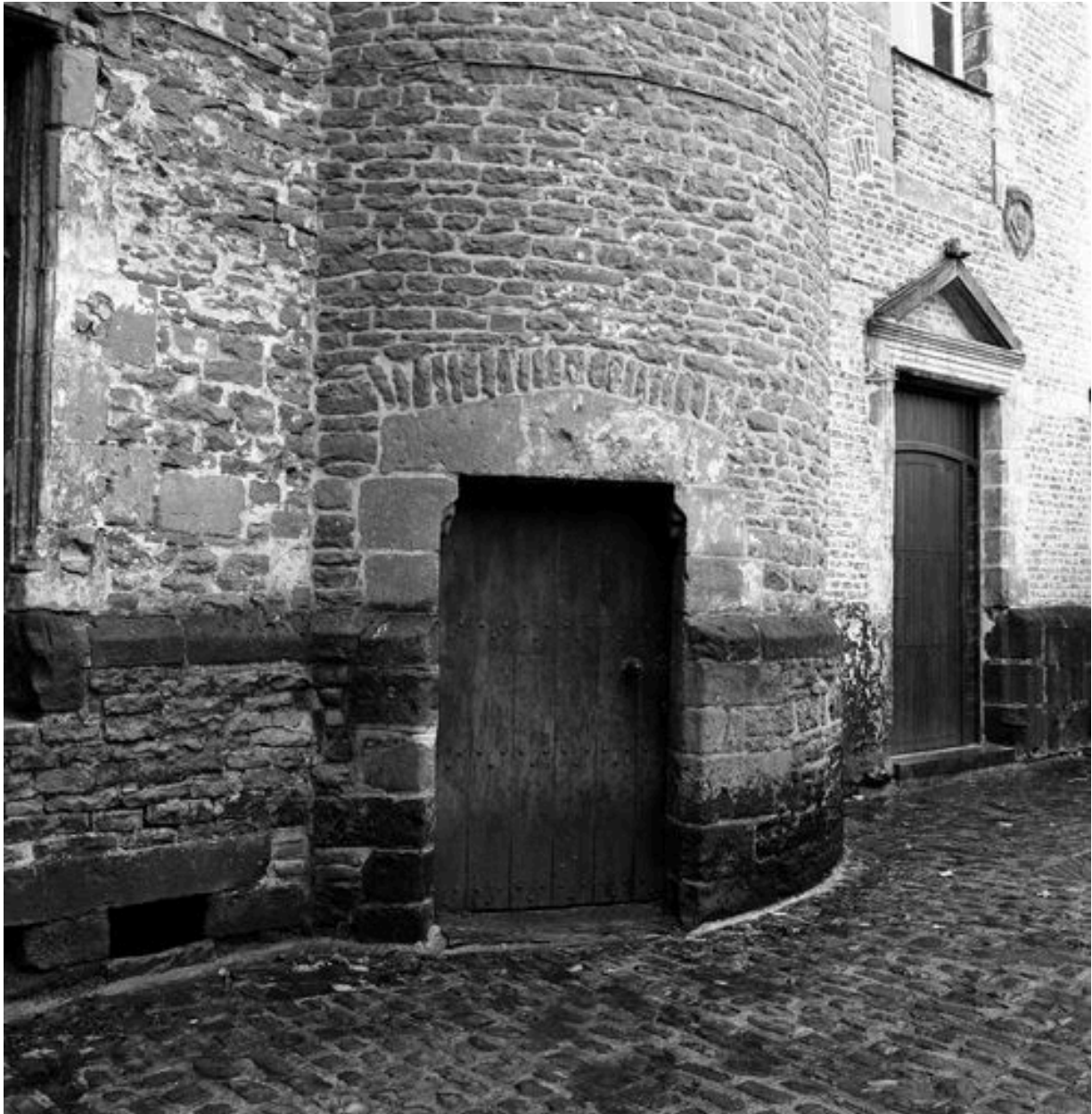
Corps de logis médiéval, façade arrière, tourelle d'escalier (ouest), vue partielle : rez-de-chaussée, porte couverte par un linteau en bâtière reposant sur des coussinets.
