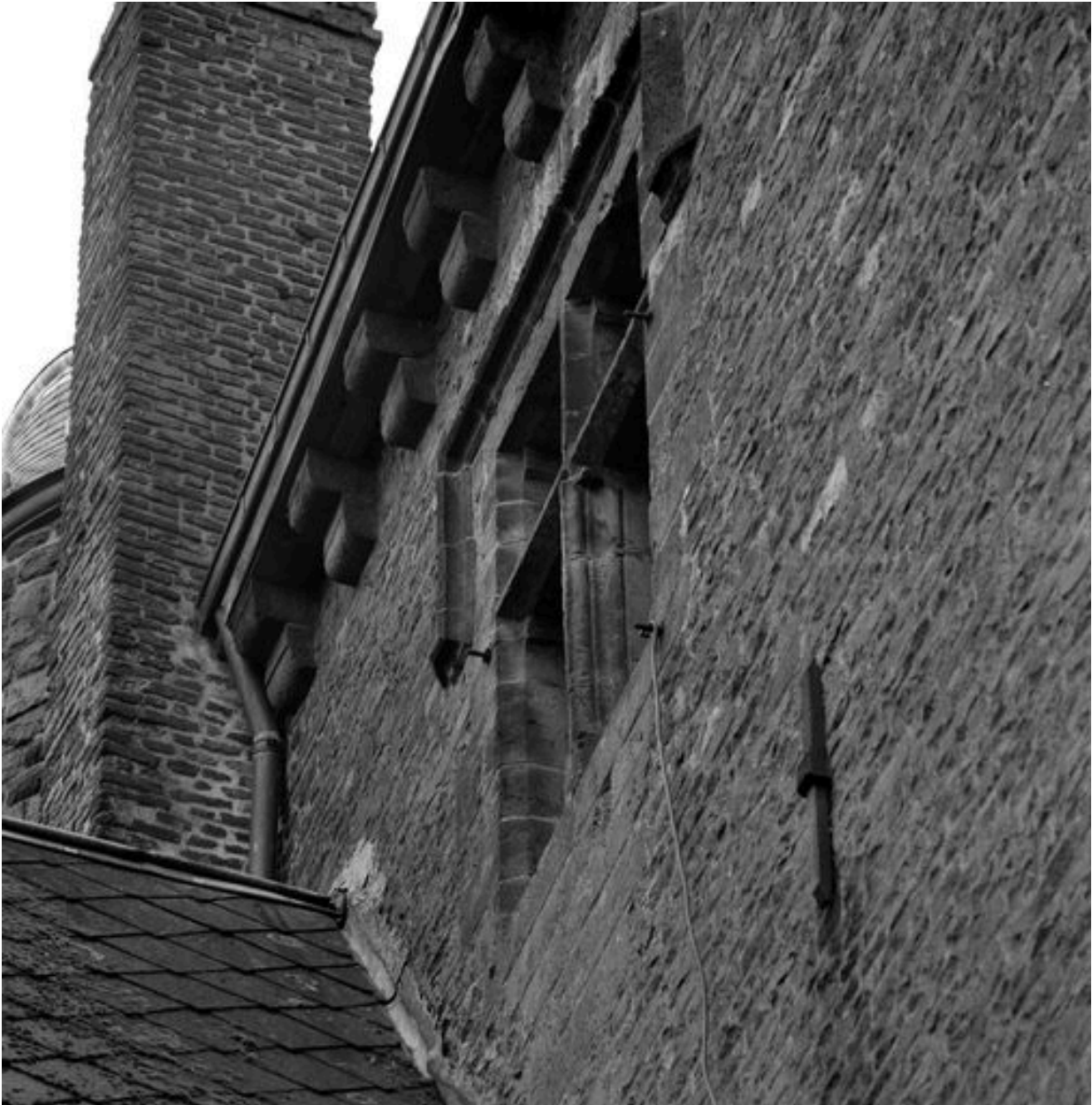
Corps de logis médiéval, façade arrière, travée nord-ouest, 2e étage, vue partielle : baie à croisée de pierre (grande salle), corbeaux de pierre.
