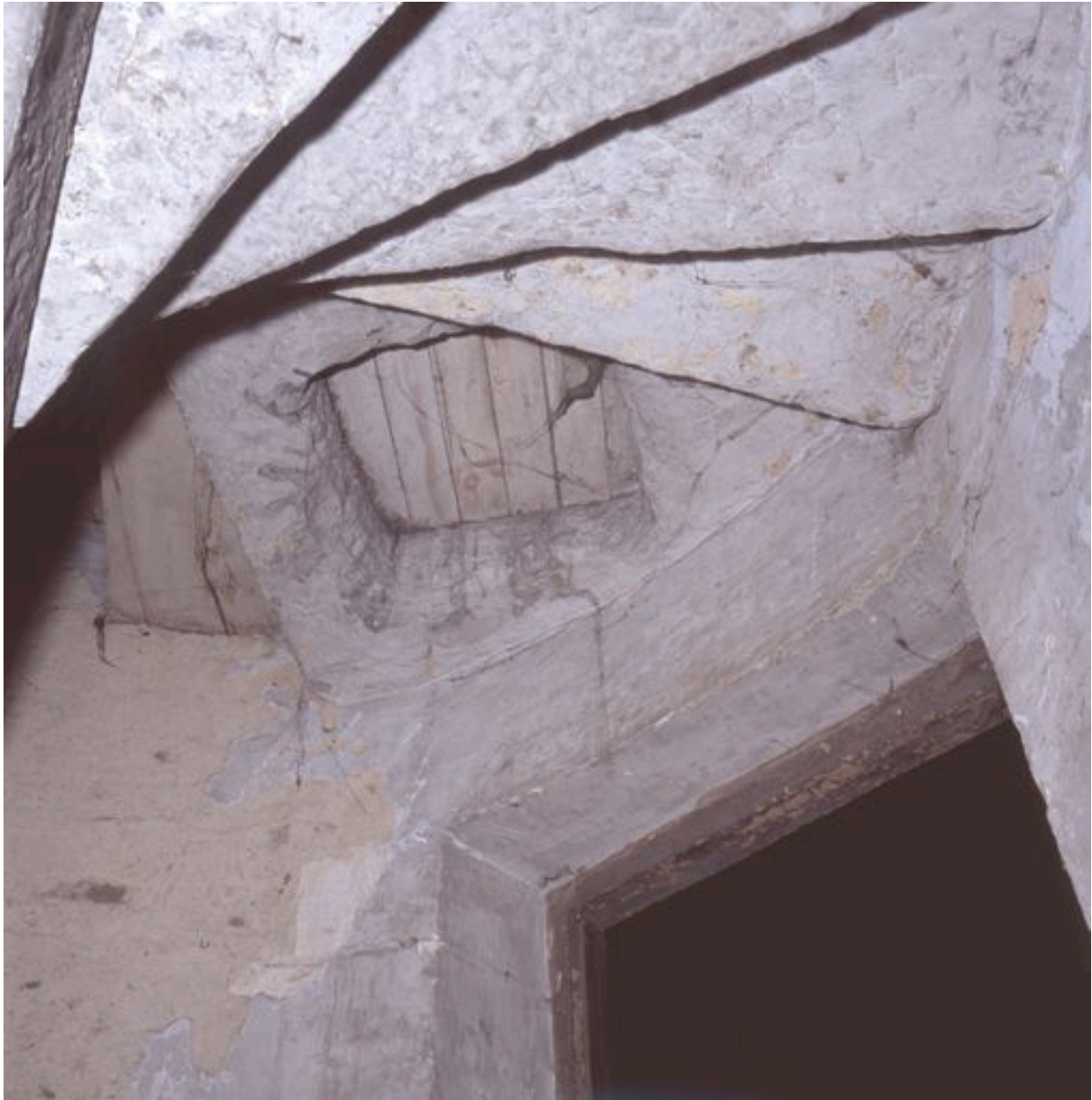
Corps de logis médiéval, intérieur, tourelle d'escalier (ouest), fin de la montée entre le 1er et le 2e étage : 2e trappe fermant la trémie.
