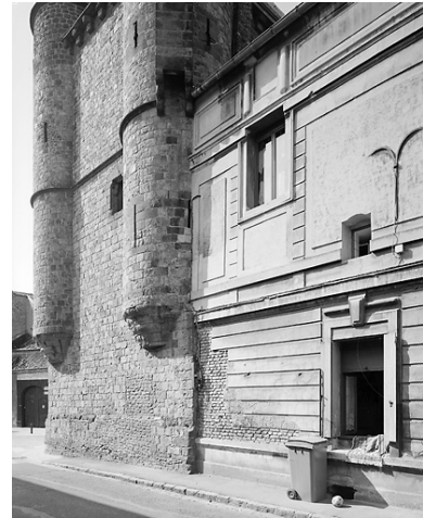
Corps de bâtiment médiéval et liaison avec l'aile sur la rue de la Bibliothèque : état en 2002. Phot. Pierre Thibaut IVR31_20025901275V
