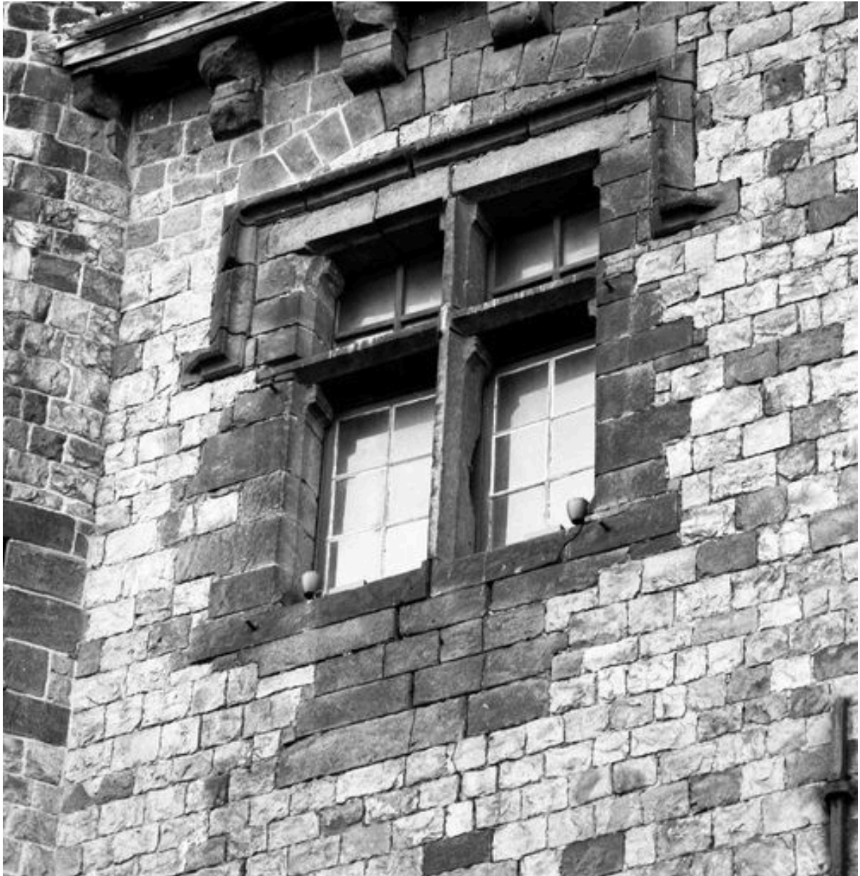
Corps de logis médiéval, façade, 2e étage, vue partielle : baie (sud-est) à croisée de pierre (grande salle).
