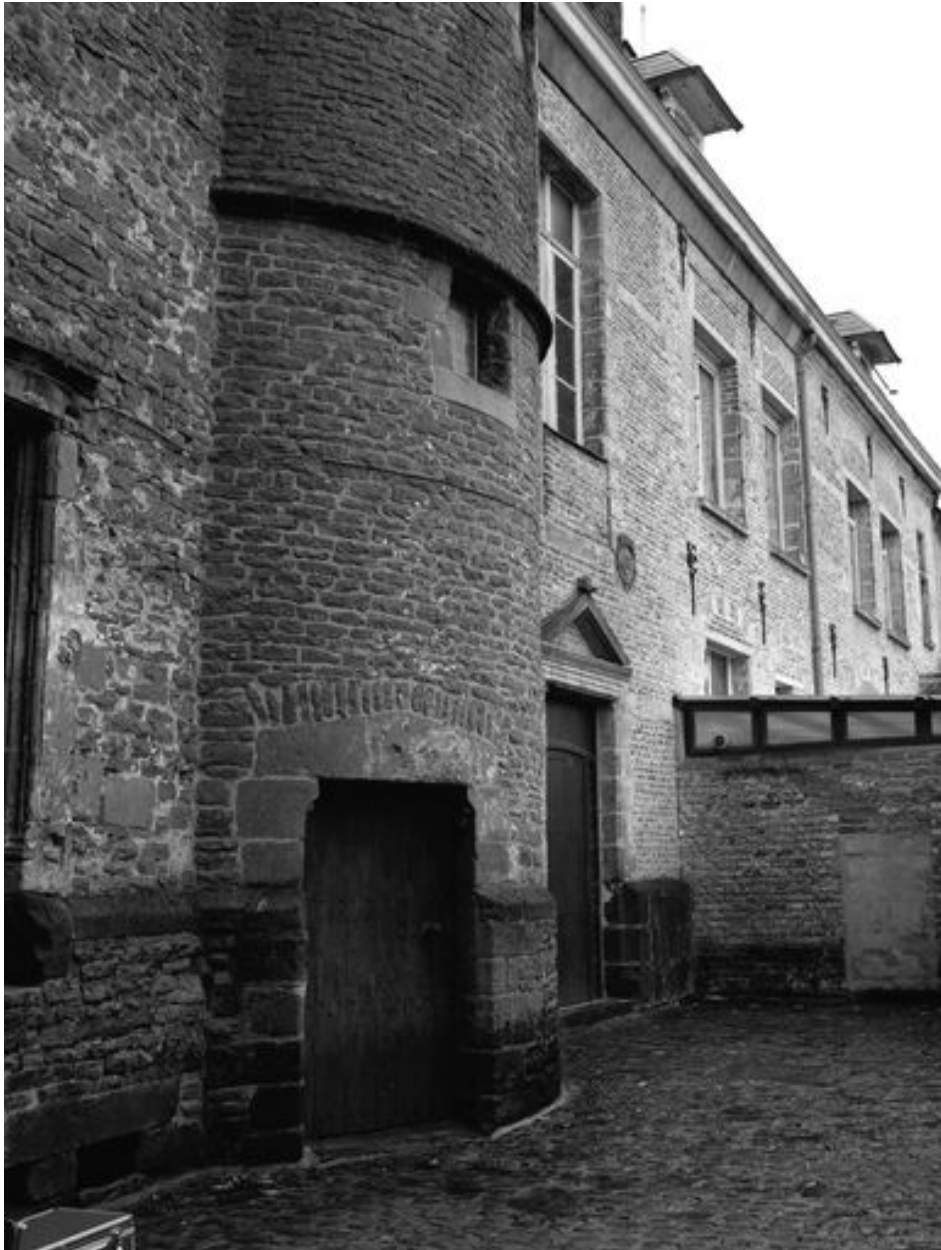
Aile de la rue de la Cavalerie, vue arrière depuis la cour du château, vue partielle : n° 35-37, et liaison avec le corps de bâtiment médiéval à gauche.
