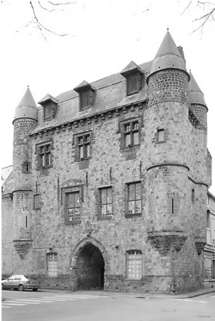
Corps de logis médiéval : vue générale depuis la place Verte, état en 2001.
