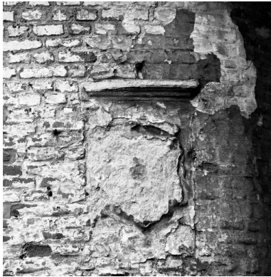
Aile de la rue de la Bibliothèque : vue depuis la cour du château, vue partielle : les deux premières travées, raccordées au corps de bâtiment médiéval, rez-de-chaussée, armoiries bûchées de Jean de Croy-Solre (1588 - 1640), époux de Jeanne de Lallaing. Phot. Pierre Thibaut IVR31_20085900758X
