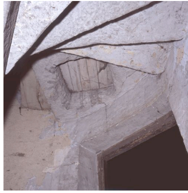
Corps de logis médiéval, intérieur, tourelle d'escalier (ouest), fin de la montée entre le 1er et le 2e étage : 2e trappe fermant la trémie. Phot. Pierre Thibaut IVR31_20085900681XA
