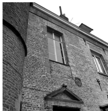
Aile de la rue de la Cavalerie : façade arrière du n° 35, vue partielle : 1er étage, reprises de percements. Phot. Pierre Thibaut IVR31_20085900760X
