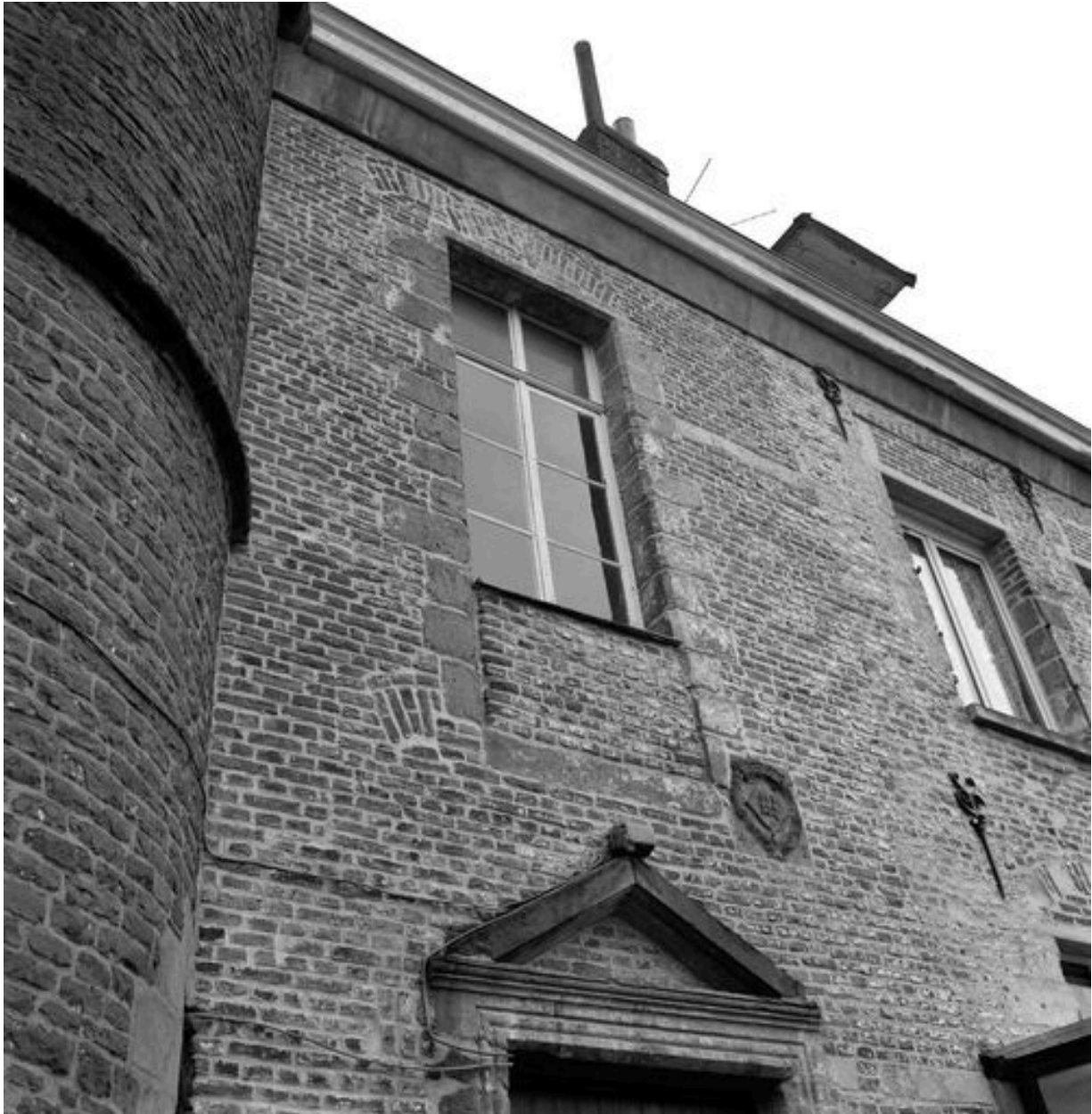
Aile de la rue de la Cavalerie : façade arrière du n° 35, vue partielle : 1er étage, reprises de percements.
