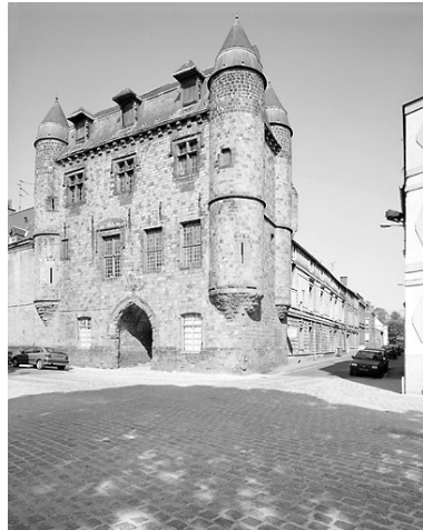
Corps de bâtiment médiéval et enfilade de l'aile sur la rue de la Bibliothèque : état en 2001. Phot. Pierre Thibaut IVR31_20015901187V
