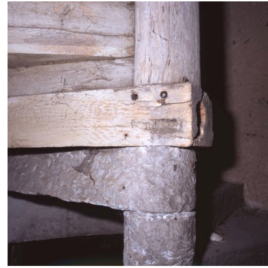
Corps de logis médiéval, intérieur, tourelle d'escalier (ouest), accès à l'étage de comble, détail : à la pierre marbrière succède le bois pour l'embranchement. Phot. Pierre Thibaut IVR31_20085900678XA
