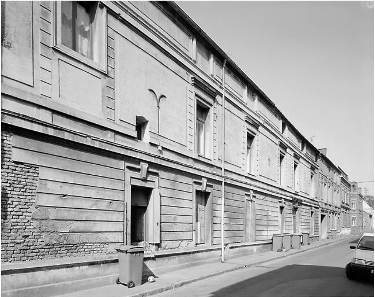
Aile de la rue de la Bibliothèque : enfilade des n° 1-3 et 5, état en 2002.
