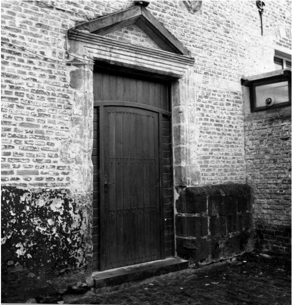
Aile de la rue de la Cavalerie : façade arrière des n° 35-37, rez-de-chaussée, porte d'accès à l'escalier "de Louis XIV" desservant actuellement le 1er étage du corps de logis médiéval.
