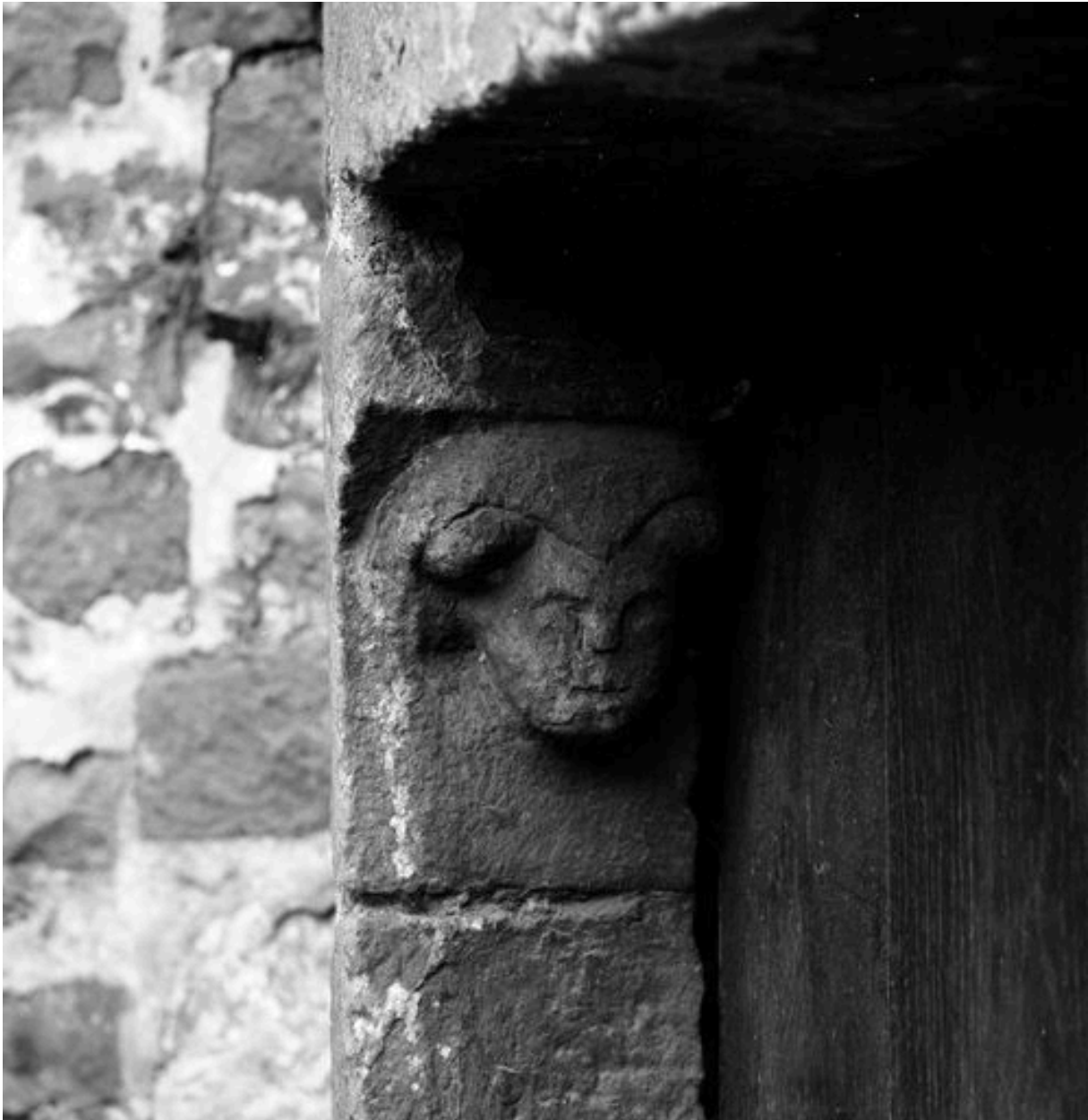
Corps de logis médiéval, façade arrière, tourelle d'escalier (ouest), rez-de-chaussée, porte d'accès, détail : tête féminine sculptée sur le coussinet portant le linteau.
