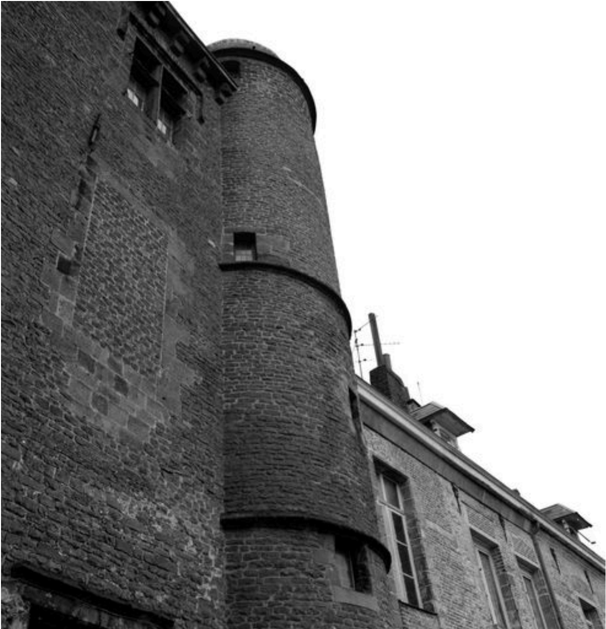
Corps de logis médiéval, façade arrière, vue partielle : baie occultée au 1er étage, baie du 2e étage (grande salle) et tourelle d'escalier (ouest).
