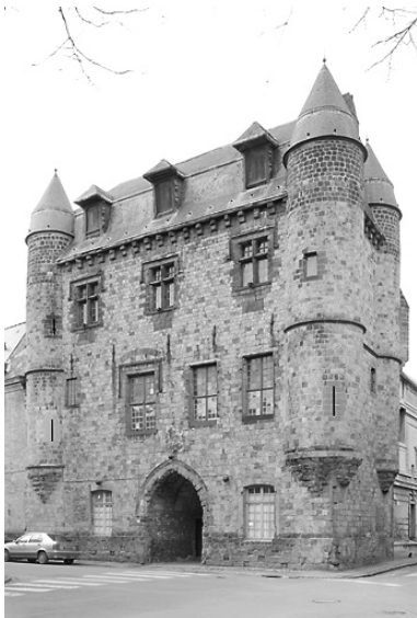
Corps de logis médiéval : vue générale depuis la place Verte, état en 2001. Phot. Pierre Thibaut IVR31_20015900534X
