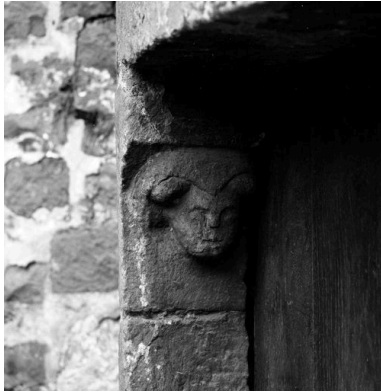
Corps de logis médiéval, façade arrière, tourelle d'escalier (ouest), rez-de-chaussée, porte d'accès, détail : tête féminine sculptée sur le coussinet portant le linteau. Phot. Pierre Thibaut IVR31_20085900755X
