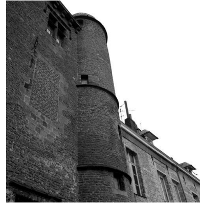
Corps de logis médiéval, façade arrière, vue partielle : baie occultée au 1er étage, baie du 2e étage (grande salle) et tourelle d'escalier (ouest). Phot. Pierre Thibaut IVR31_20085900762X
