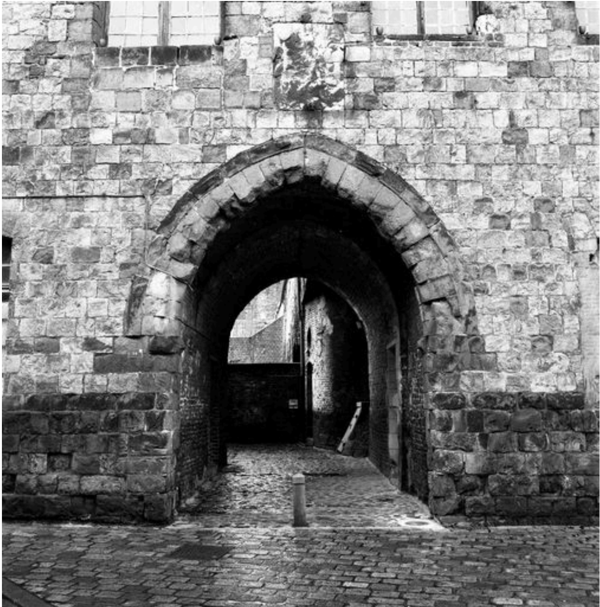
Corps de logis médiéval, façade, rez-de-chaussée, vue partielle : passage couvert ; à l'aplomb du passage, armoiries bûchées de Jean de la Hamaide, qui étaient accompagnées de la date de 1411.
