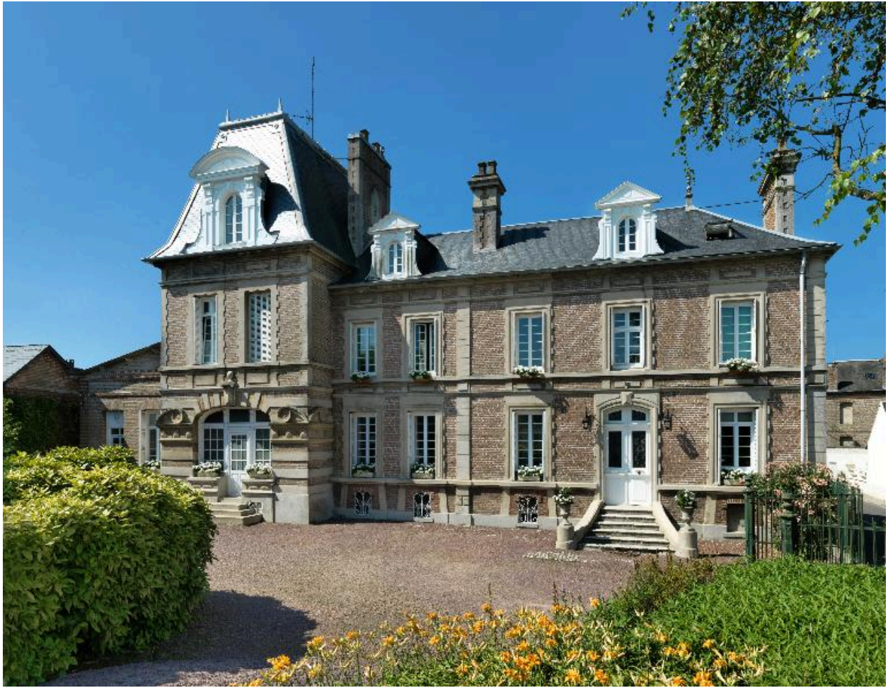
Vue de la façade antérieure.
