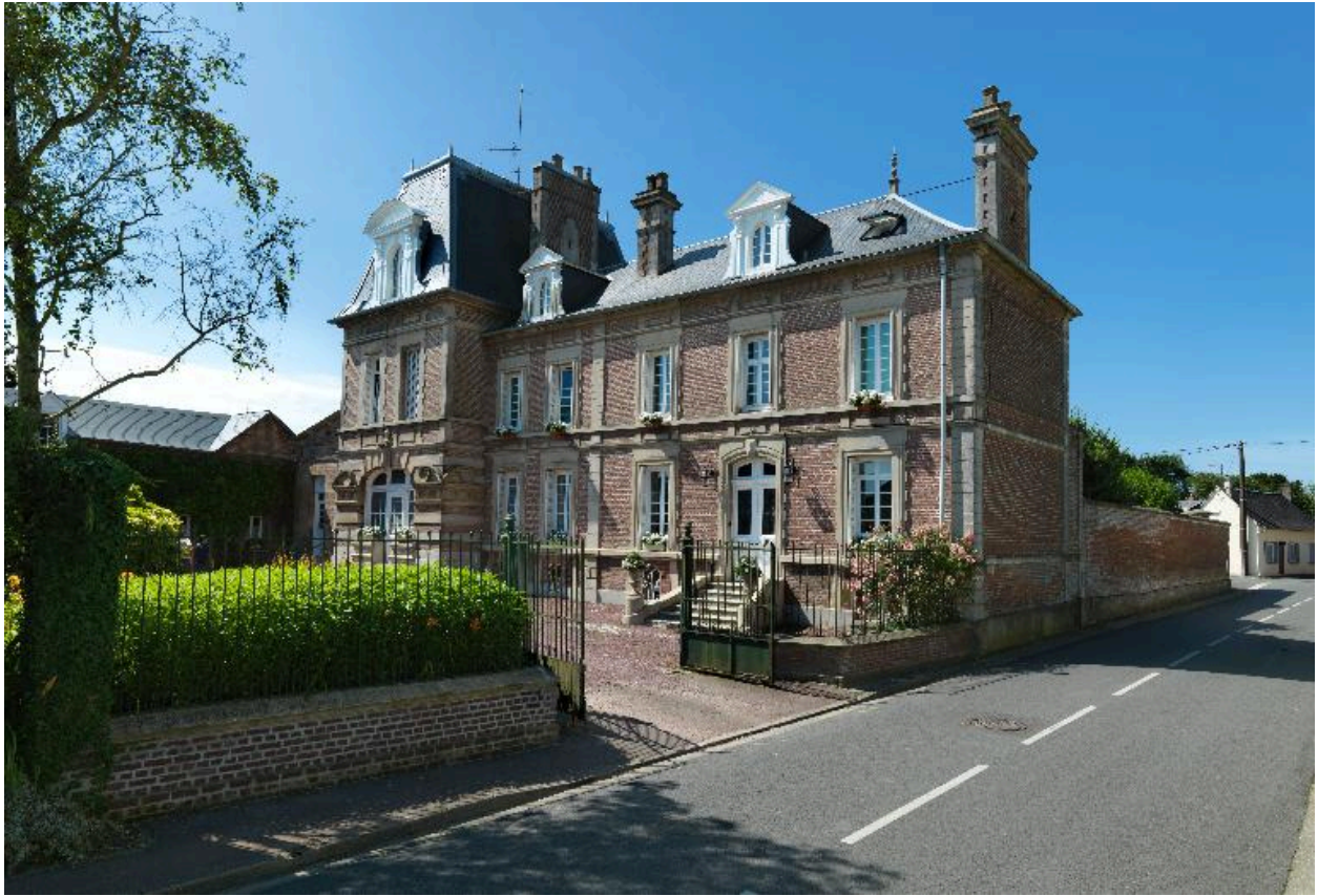
Vue générale de la demeure de l'industriel Léon Hurtel, depuis la rue Achille-Pruvost.
