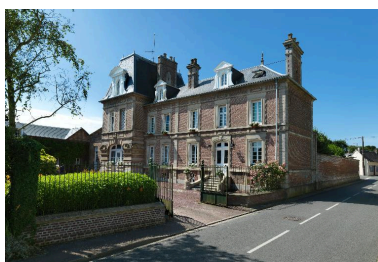
Vue générale de la demeure de l'industriel Léon Hurtel, depuis la rue Achille-Pruvost. Phot. Frédéric-Nicolas Kocourek IVR22_20148000450NUC2A
