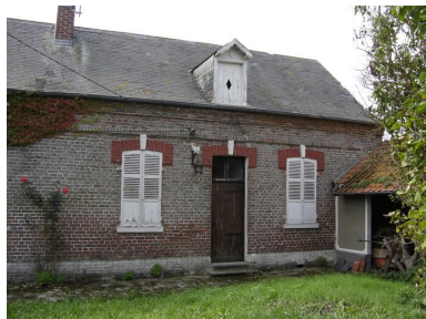
Vue de la partie ouest de l'habitation.
