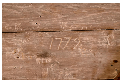
Date "1772" gravée sur la voûte lambrissée du chœur. Phot. Marc Kérignard IVR32_20226000799NUCA
