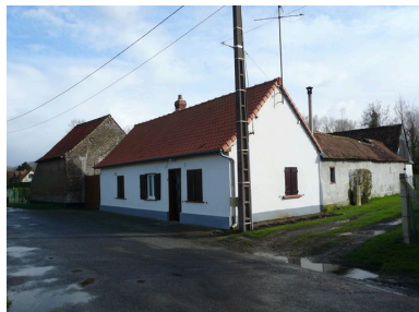
Vue générale. Phot. Inès Guérin IVR22_20078005559NUCA
