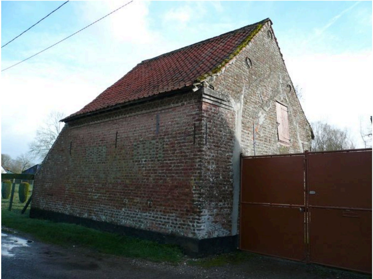
Vue de l'étable sur rue.
