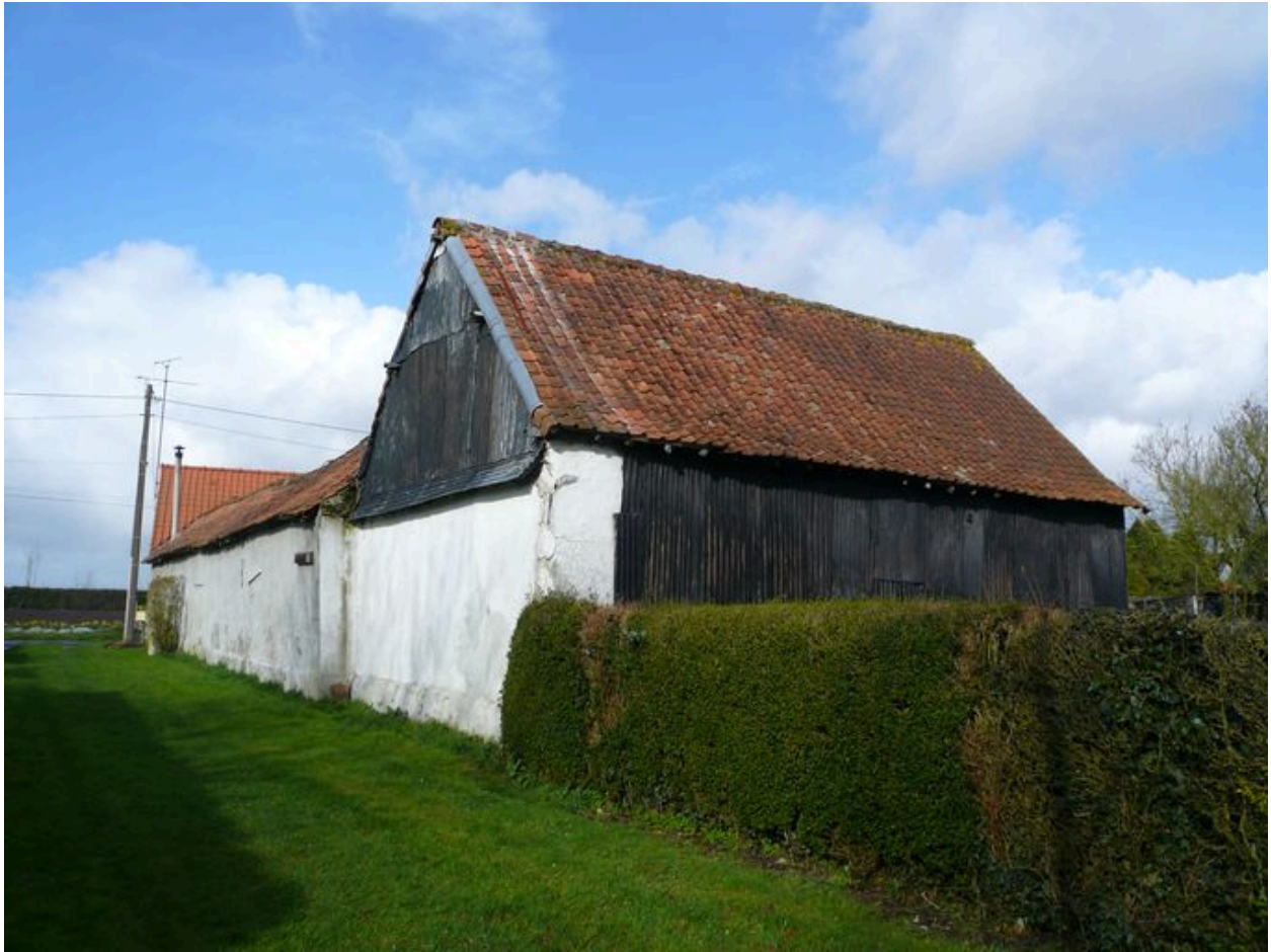
Vue générale postérieure.
