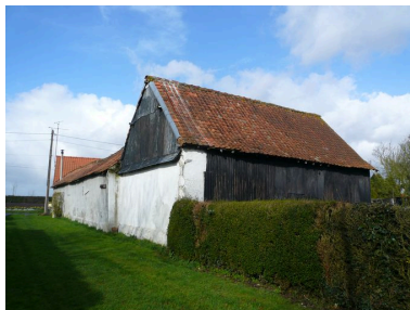
Vue générale postérieure. Phot. Inès Guérin IVR22_20078005560NUCA
