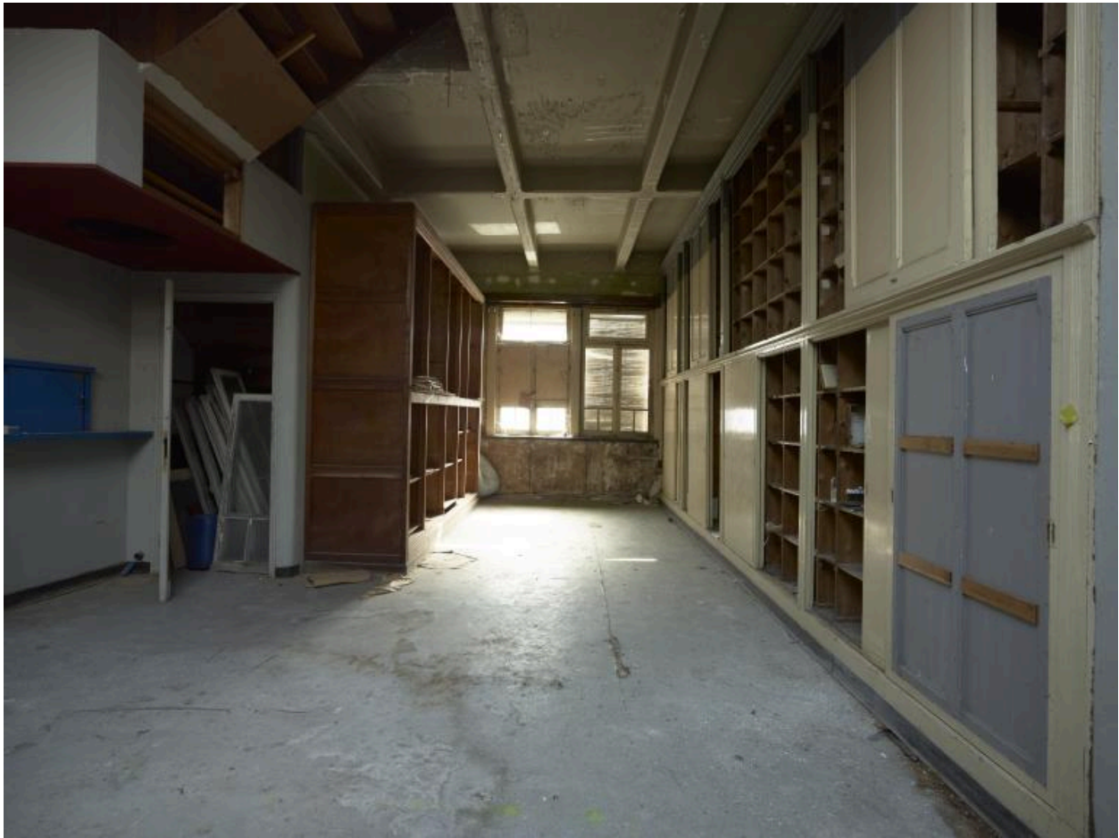
Bureaux. Salle des archives au premier étage.
