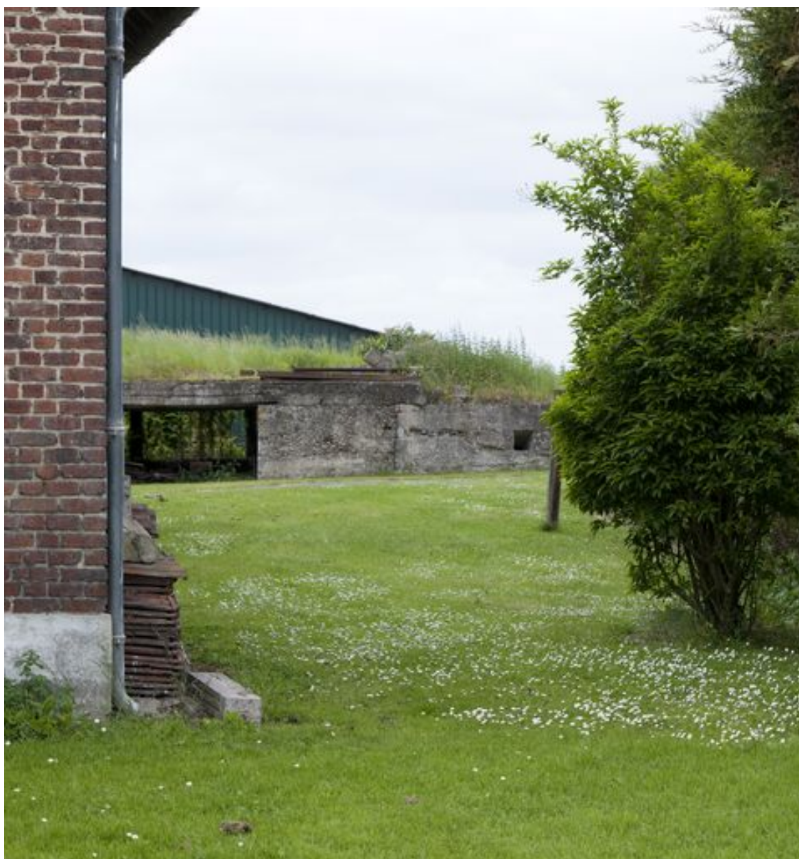
Vue de l'édifice depuis la rue
