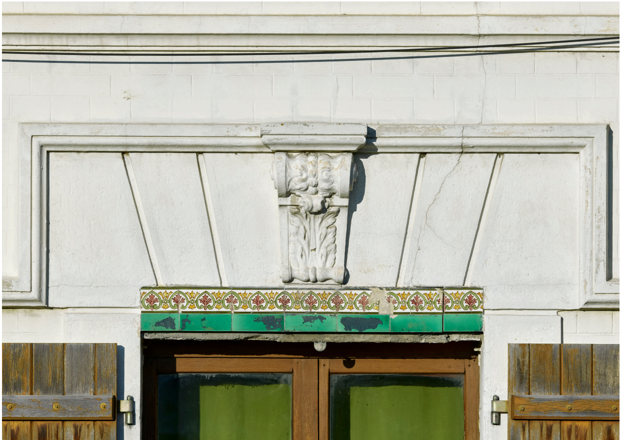
Détail des céramiques sous les linteaux des ouvertures.
