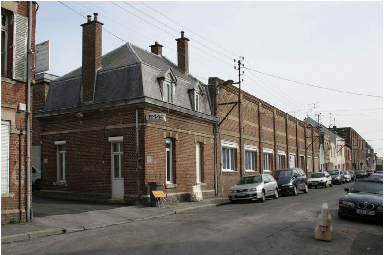
Entrée de la cour de l'usine, conciergerie et atelier de broderie de 1912, rue Denfert-Rochereau.
