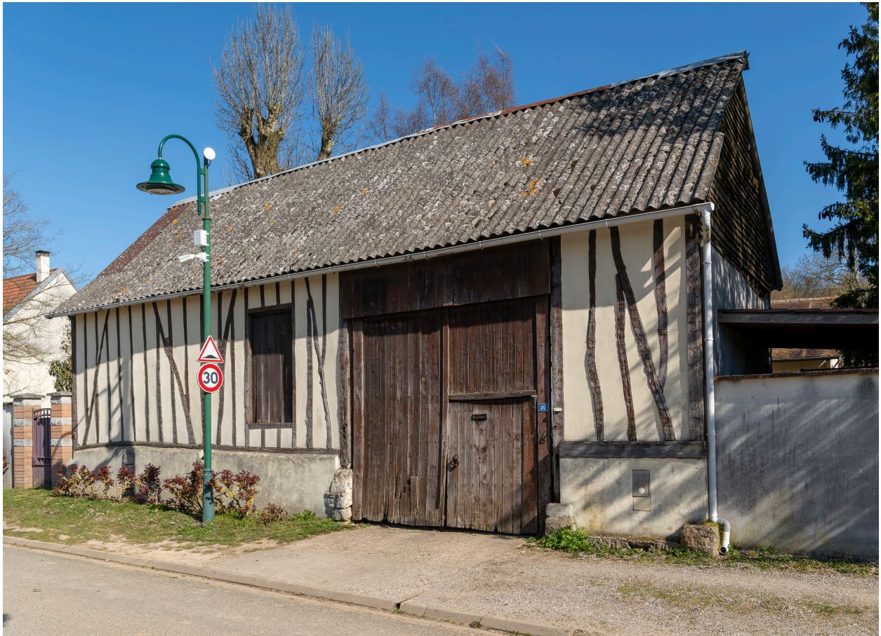
Ancienne grange sur rue avec entrée charretière et porte à engranger, n°20 de la rue Lefèvre, vue depuis le sud-ouest.
