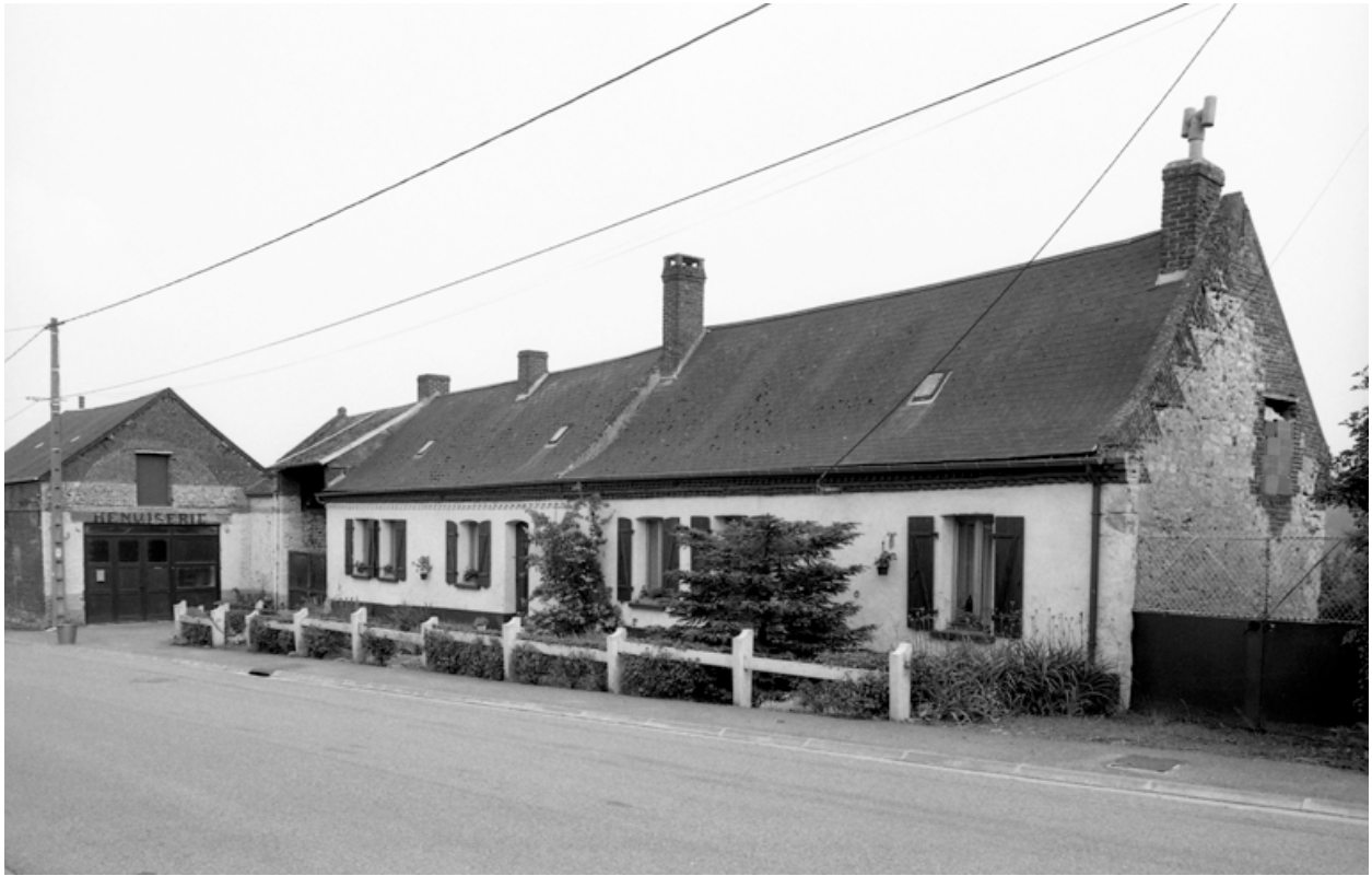
Vue d'ensemble de l'élévation sur rue.
