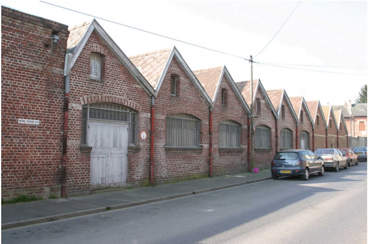
Les ateliers vus depuis la rue Pierre de Corbie.
