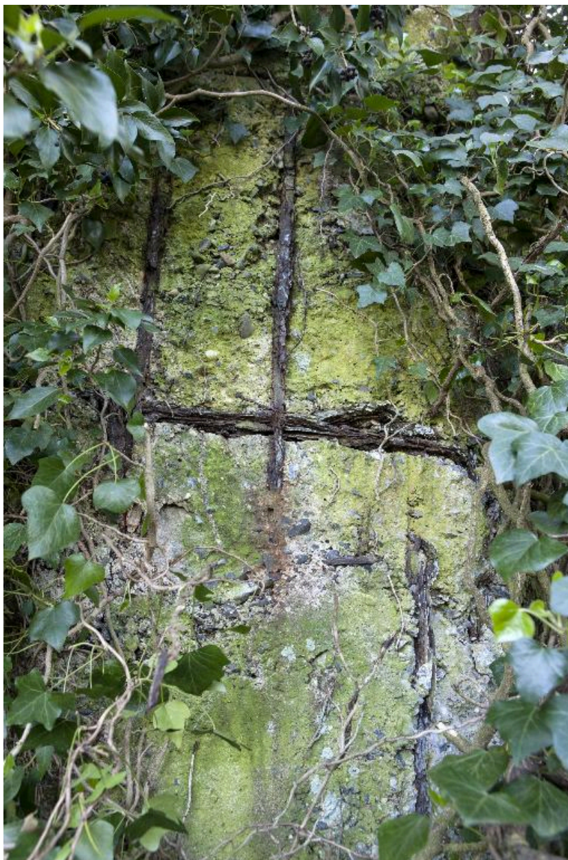
Elévation est, détail des fers apparents
