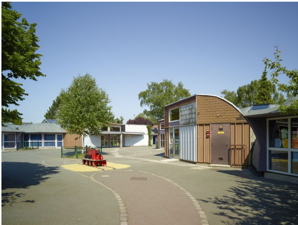
Vue de la cour et entrée de l'école maternelle (à droite).
