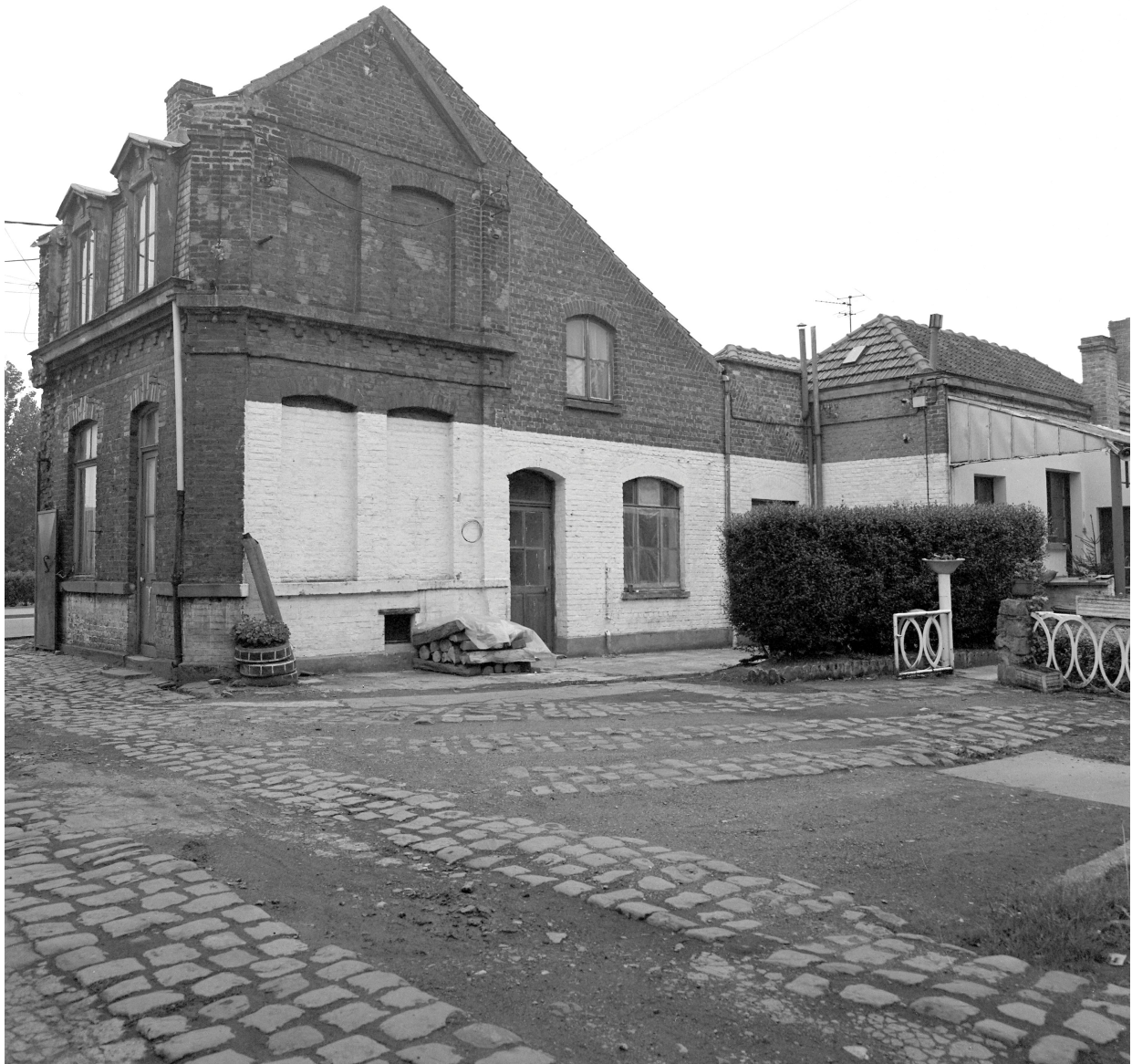
Conciergerie, élévation sur cour.
