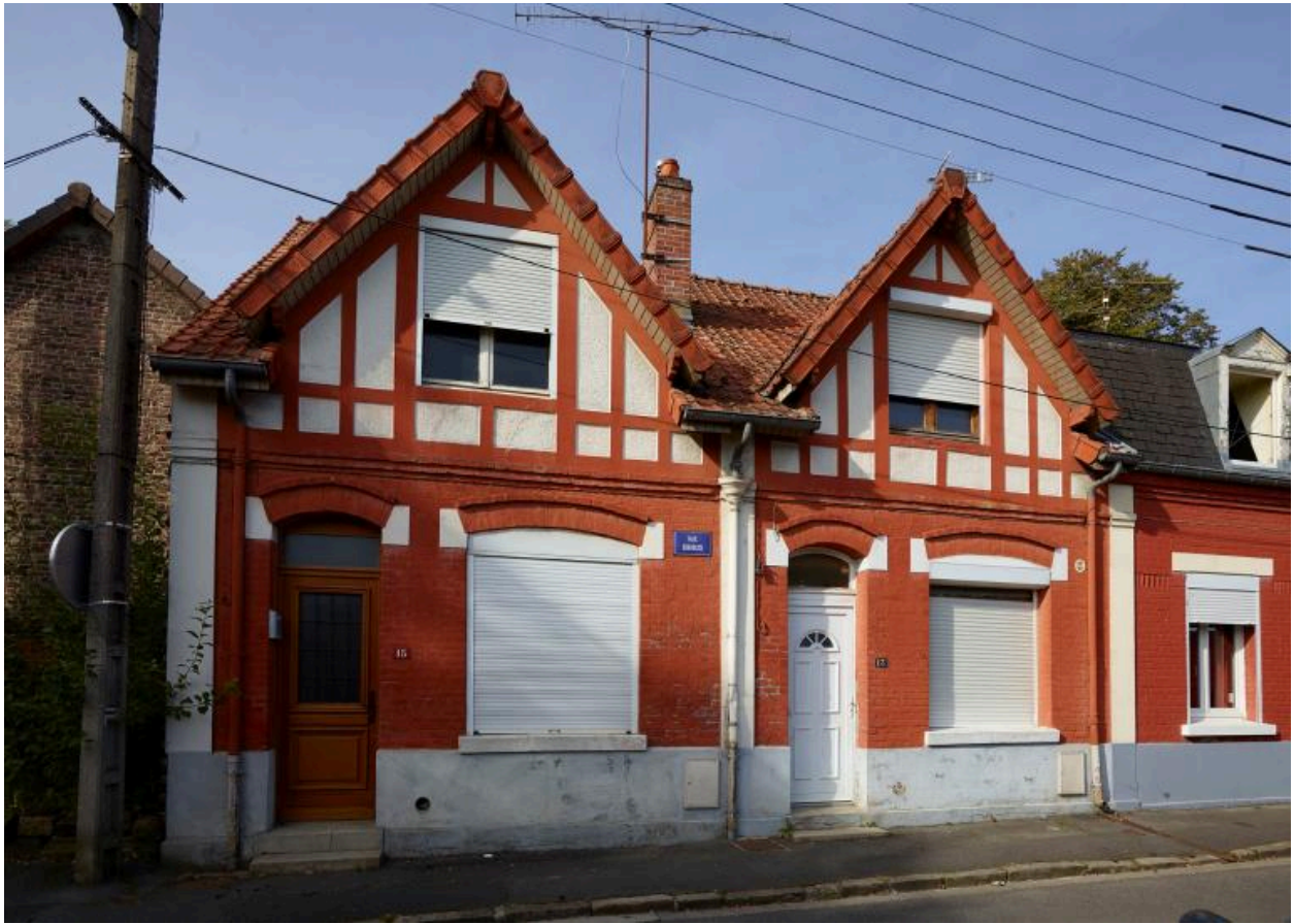
Maison à deux unités d'habitation, n°13-15 rue Oribus. Vue de la façade principale depuis la rue. Etage sous comble décoré de faux pans de bois en béton.
