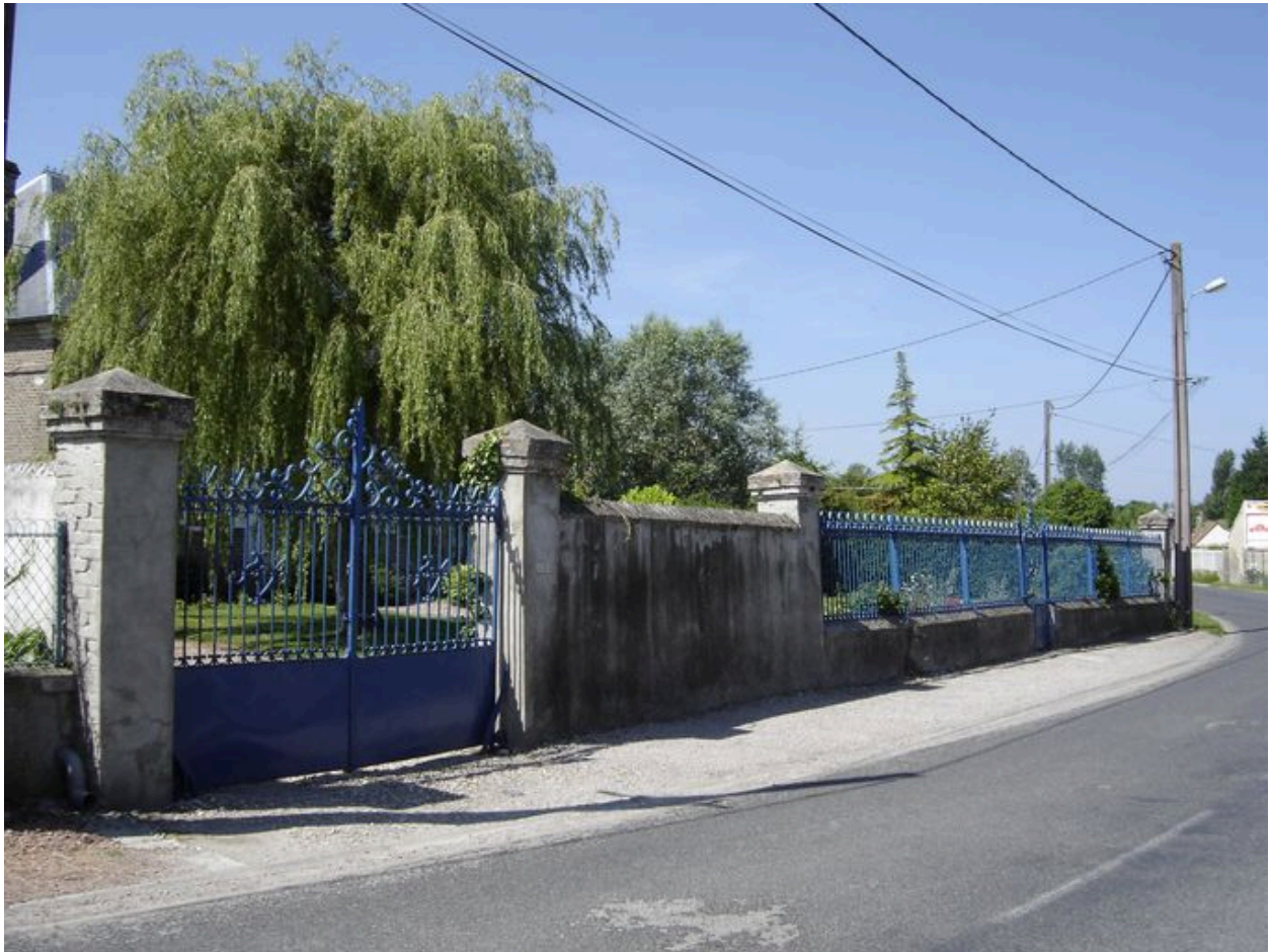
Mur de clôture avec piliers d'entrée
