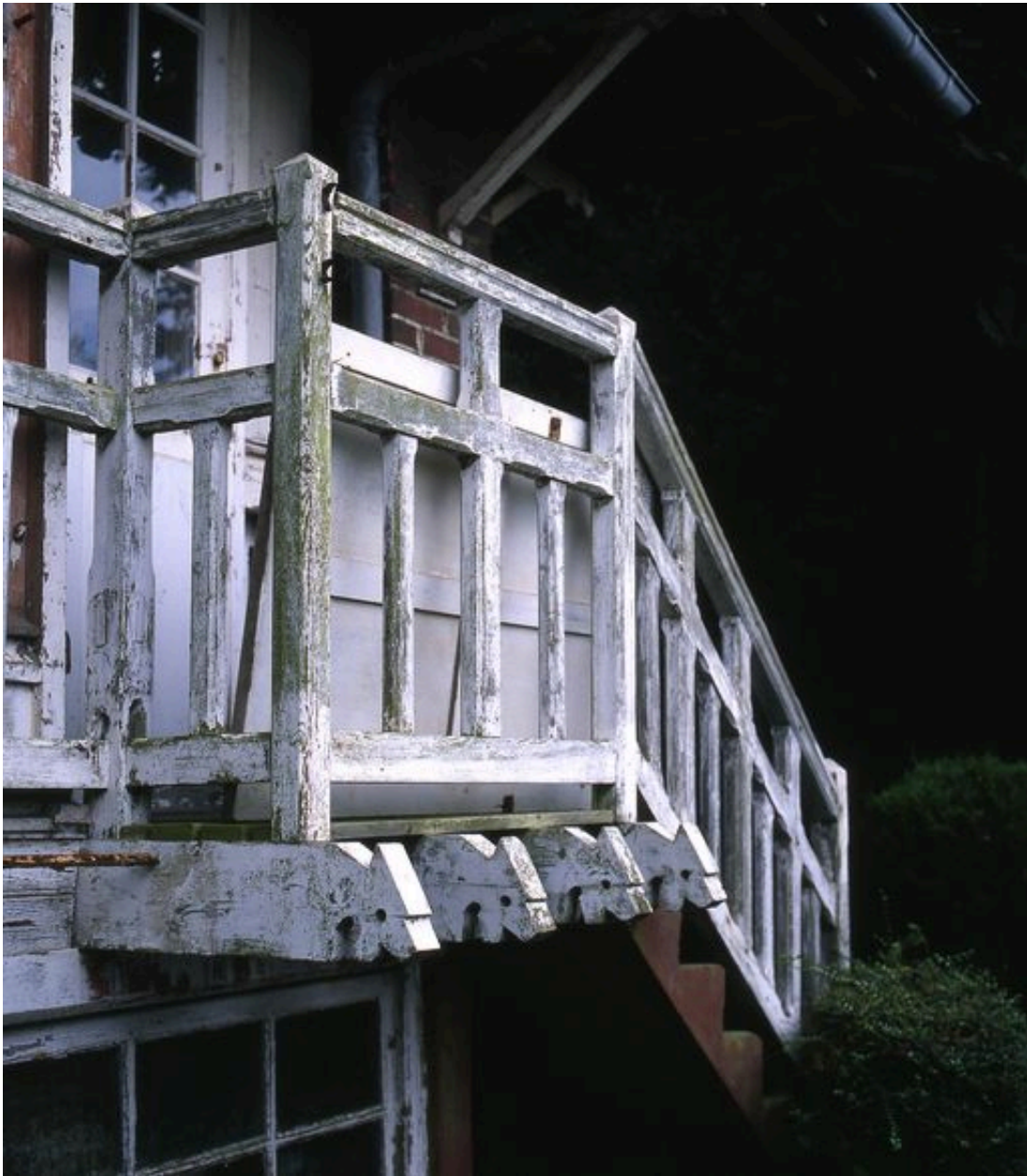
Détail des menuiseries extérieures.
