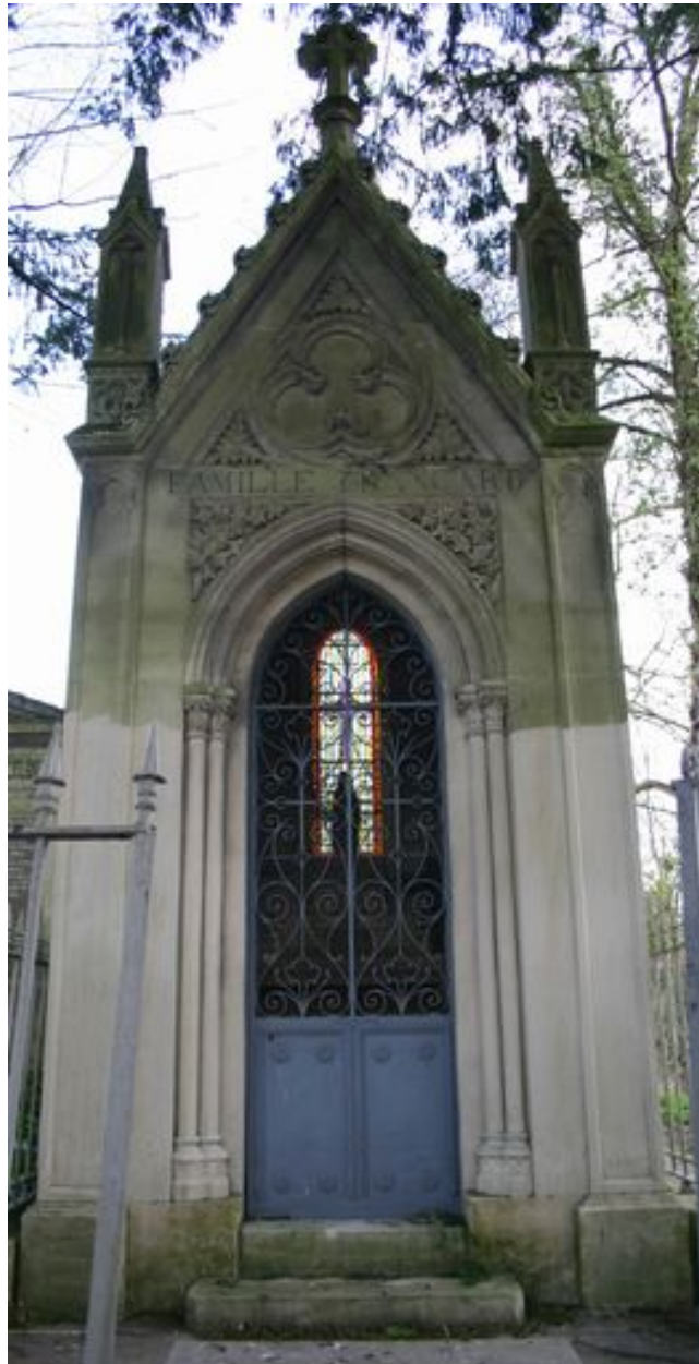
Vue rapprochée de la façade principale.
