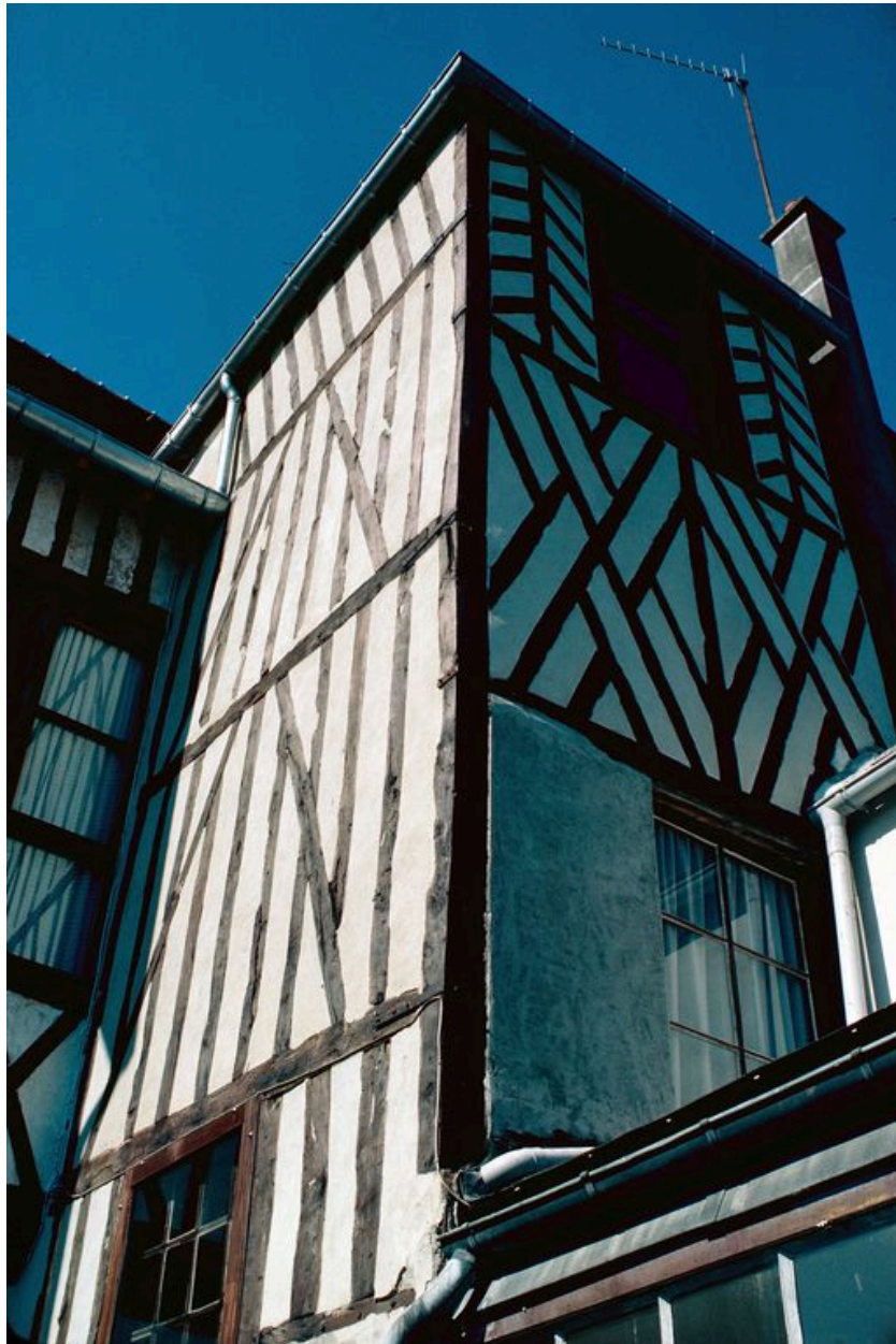
Elévation postérieure : détail de l'escalier hors-oeuvre.
