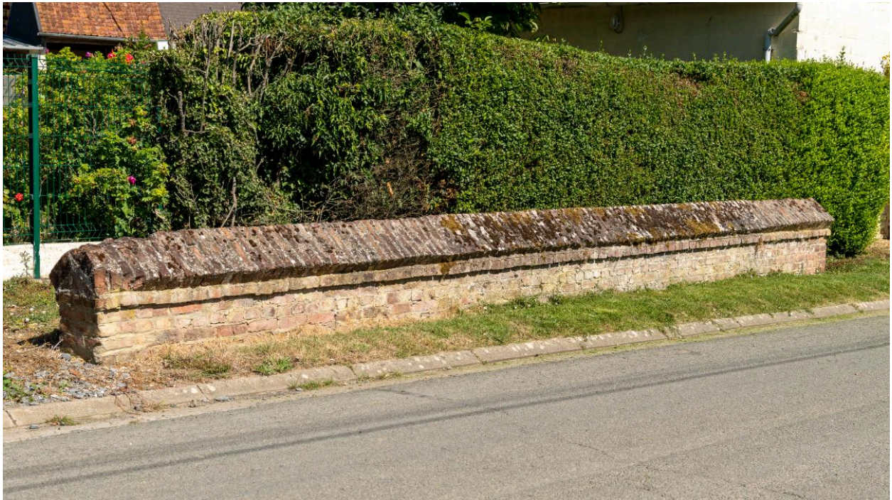
Mur d'une ancienne mare de La Neuve Rue, vue depuis l'est.
