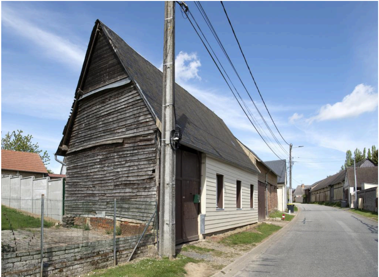
Pignon avec un essentage ancien en clins de bois, n°9 rue Principale, vue depuis le sud-est.
