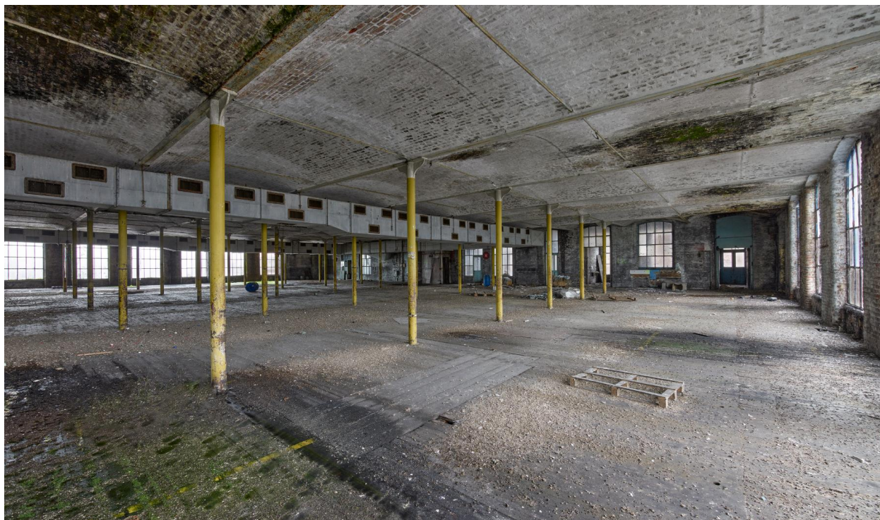
Vue générale du 2e étage de l'atelier de fabrication (bâtiment K).
