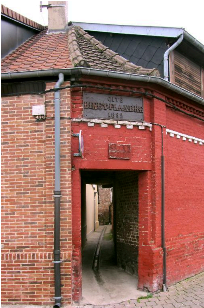
Détail du passage desservant l'arrière de la cité ouvrière.
