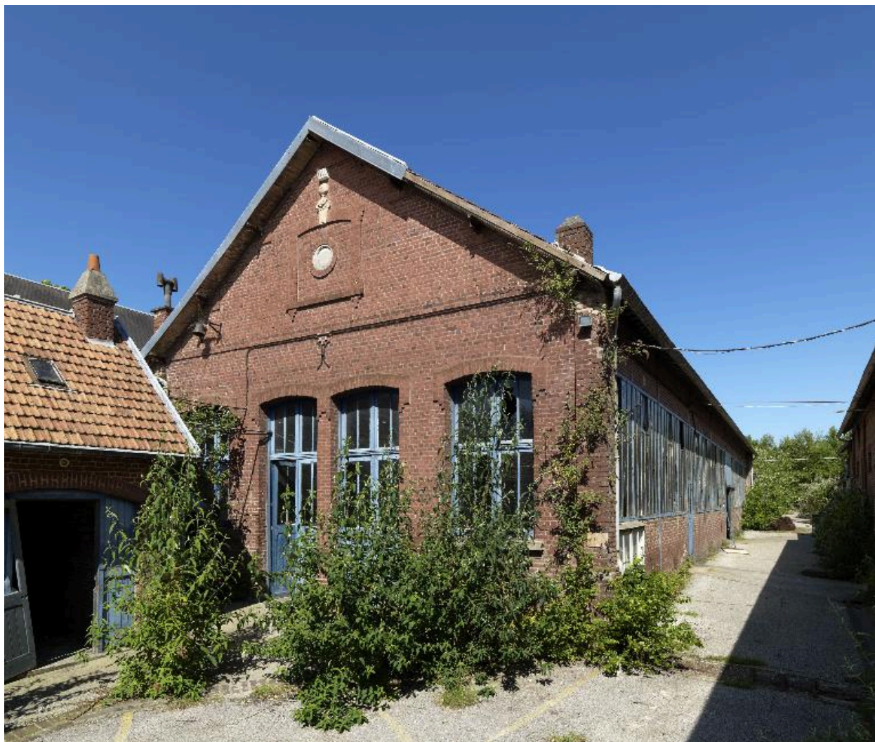
Ancien atelier de fabrication.
