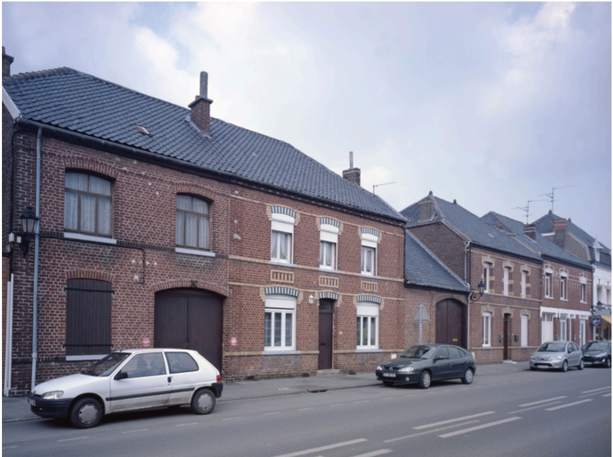
Alignement de maisons de bourg : 114-52, rue de l'Eglise, côté nord.
