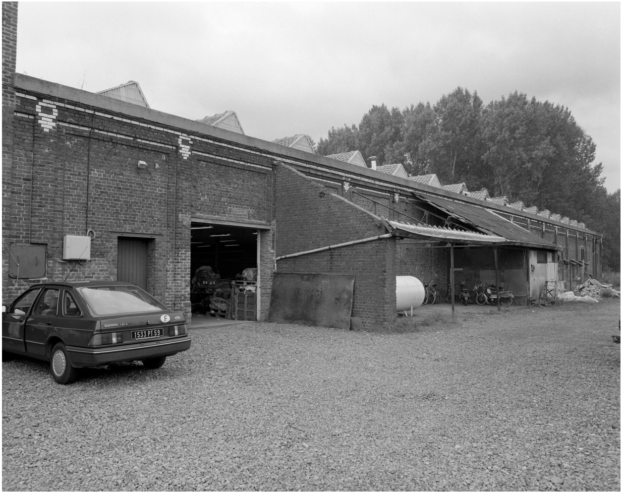
Élévation sud-est. Vue prise vers le nord. Ancien embranchement ferroviaire et hangar aux déchets.
