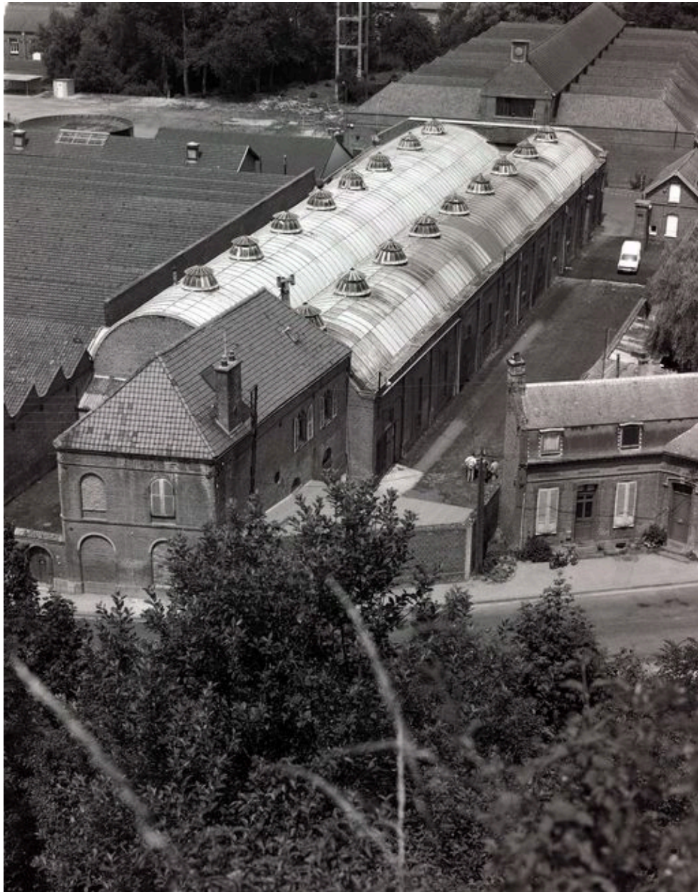
Vue partielle de l'usine, en 1989 : flanc est (logement au 1er plan, atelier de fabrication au 2e plan et entrepôt au 3e plan).
