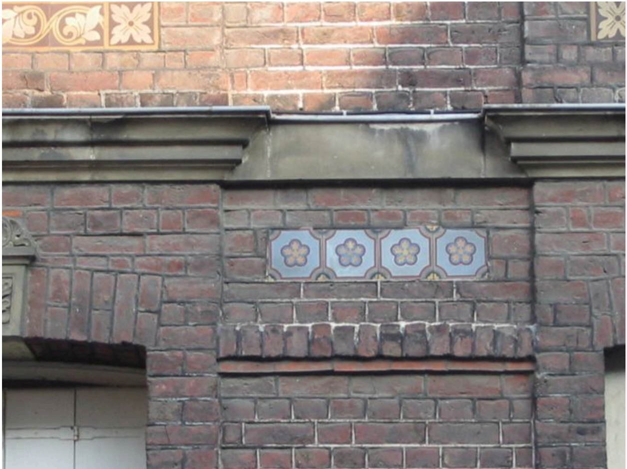
Façade latérale, plein de travée : décor en carreaux de céramique.
