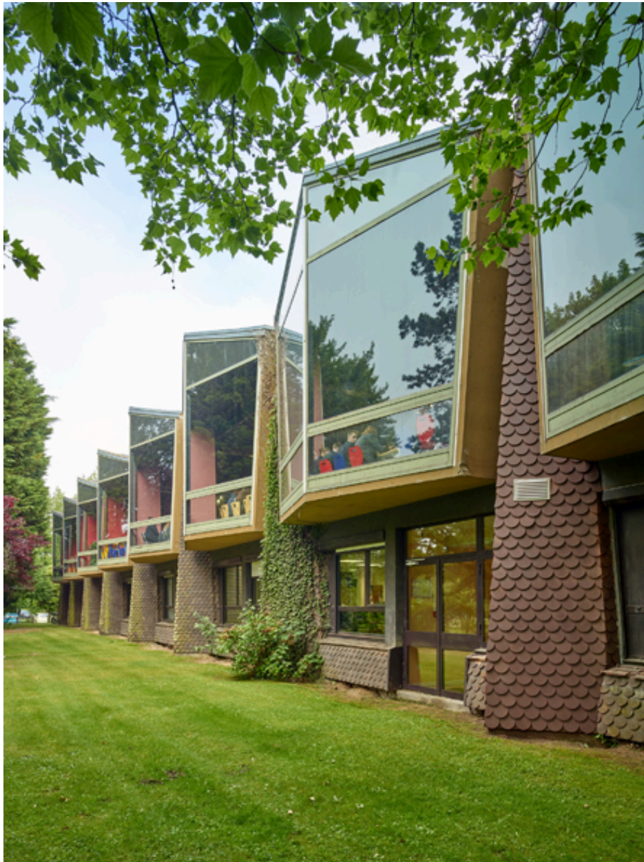
Vue générale de trois quarts de l'élévation des anciens restaurants d'application, côté nord.
