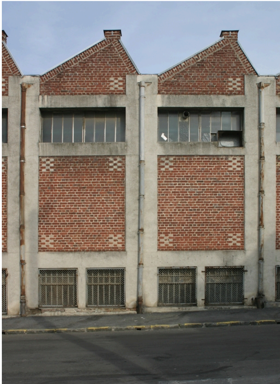
Détail des ateliers, rue Félix-Davin.
