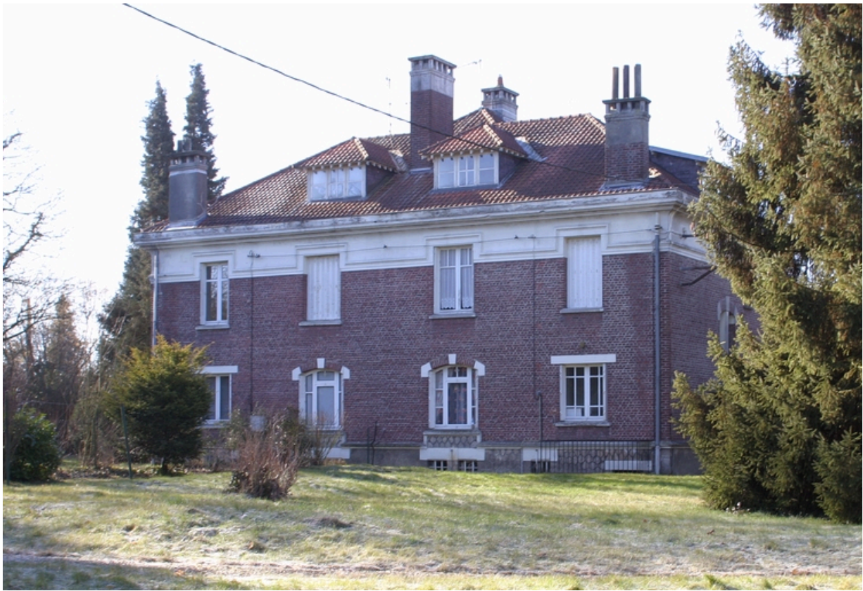
Bâtiment à deux logements de 1926-1928, façade postérieure.
