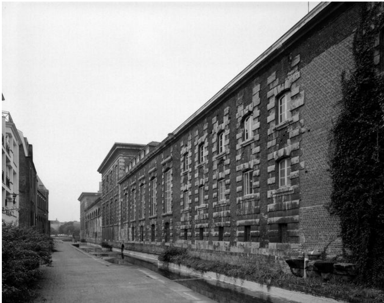
Elévation latérale droite donnant sur le canal de l'Escaut, vue générale prise de trois-quarts droit.
