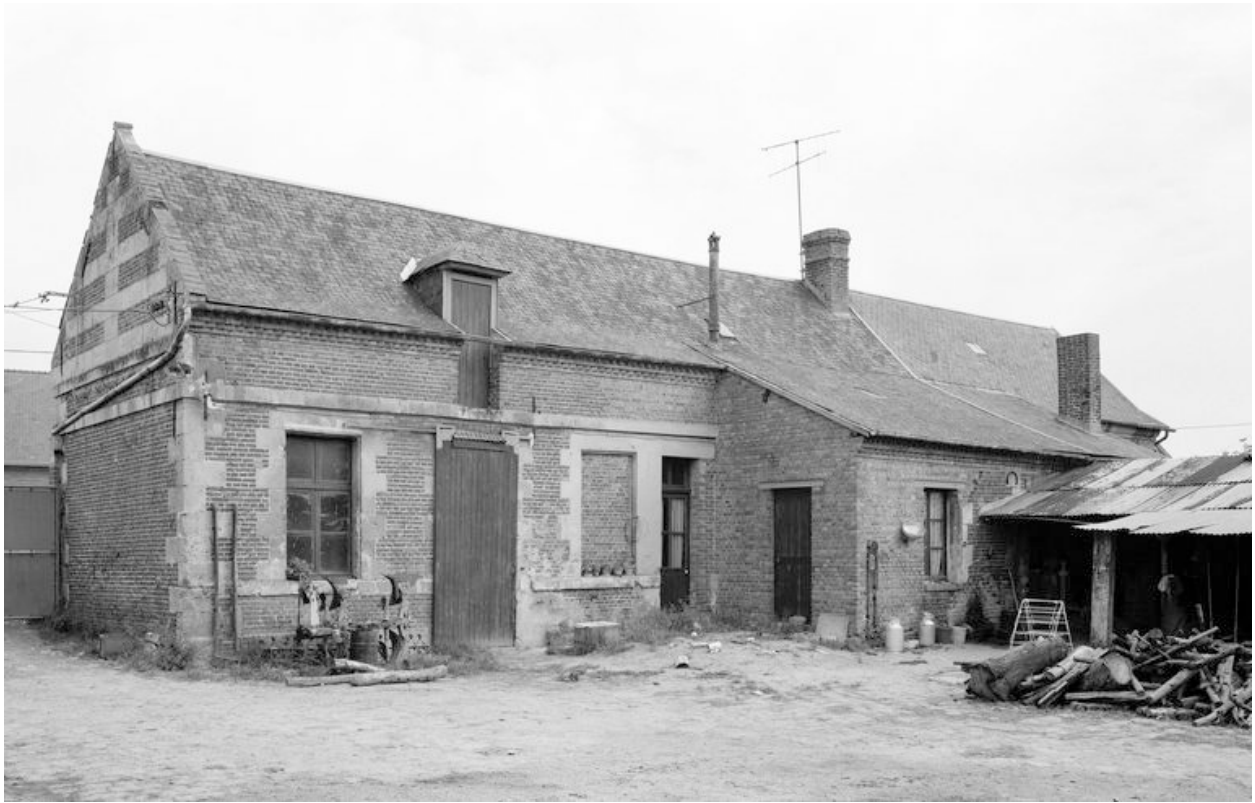
Logis. Élévation sur cour.
