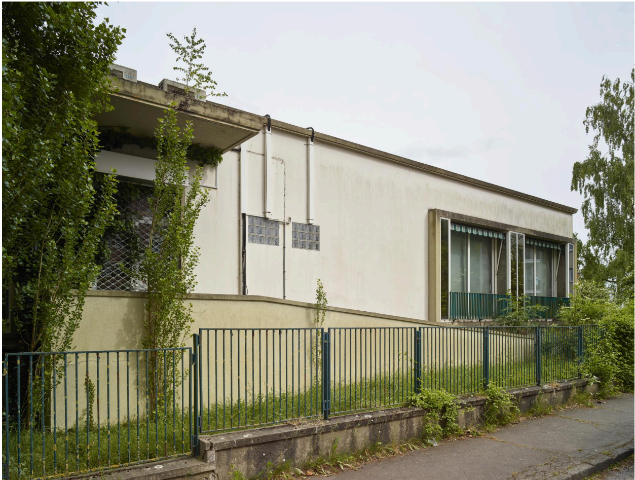
Vue de l'entrée de la CAF, côté ouest.
