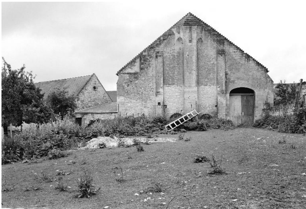
Vue de l'élévation nord-ouest de la grange.
