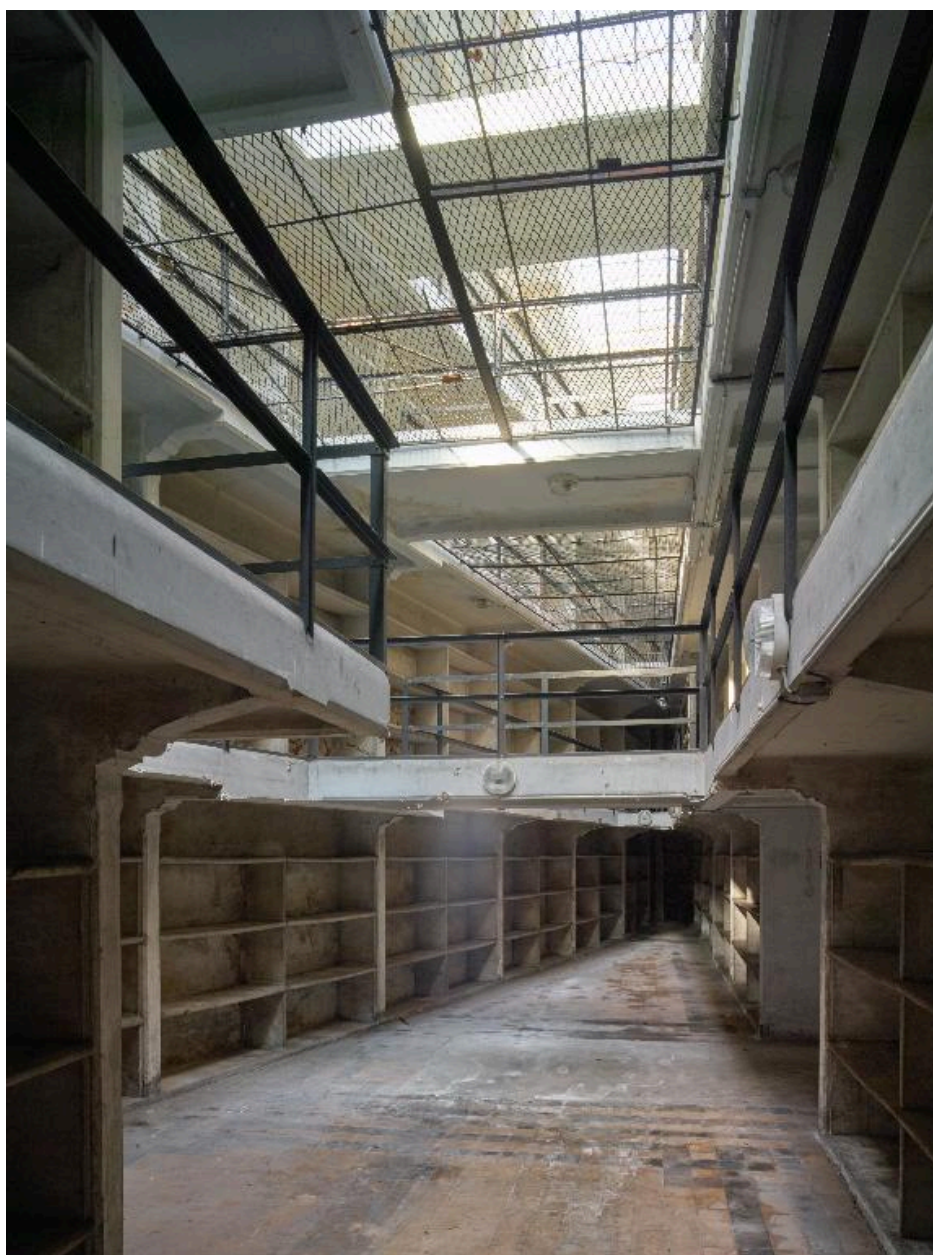
Bâtiment du dépôt, rez-de-chaussée : vue du vaisseau 4 vers l'ouest.
