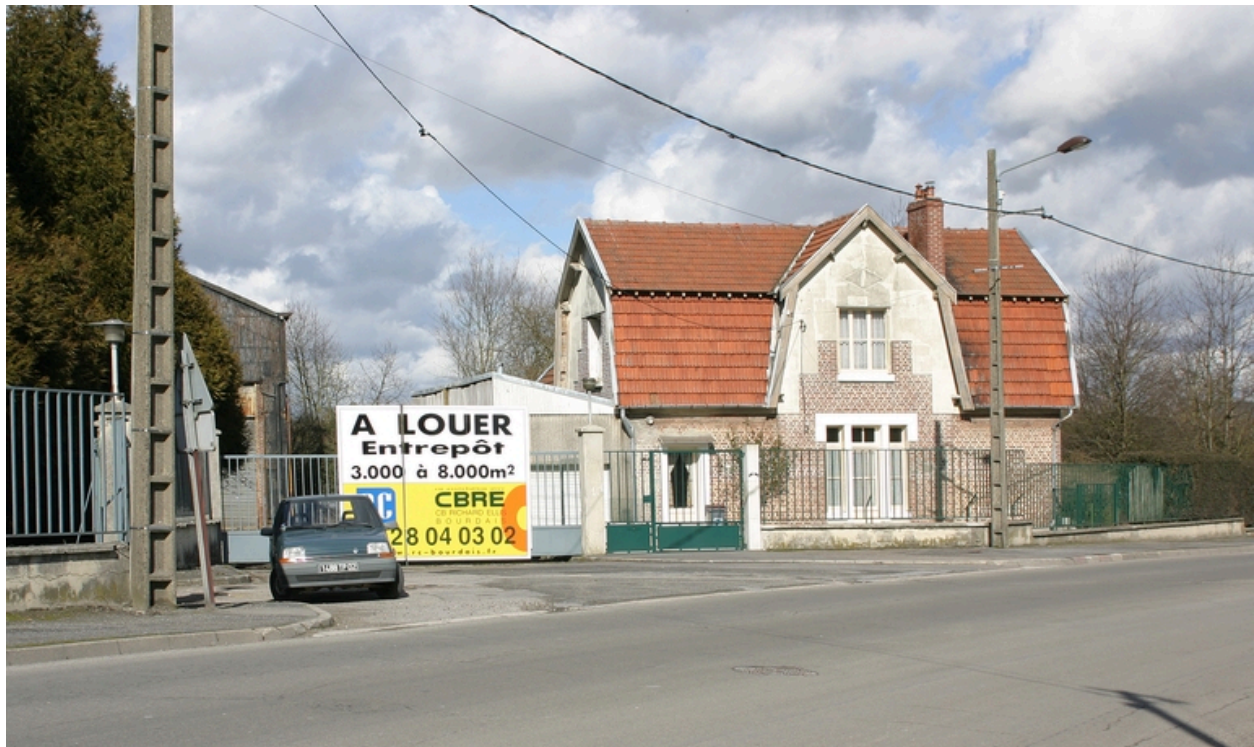
Entrée du site, route de Chauny.
