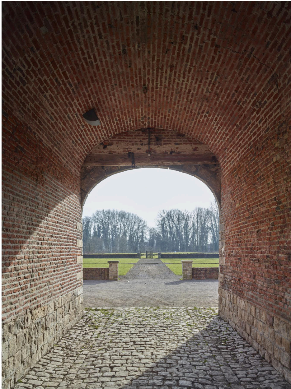
Passage charretier. Vue prise vers la cour intérieure. Poutre contenant le chronographe "1725".
