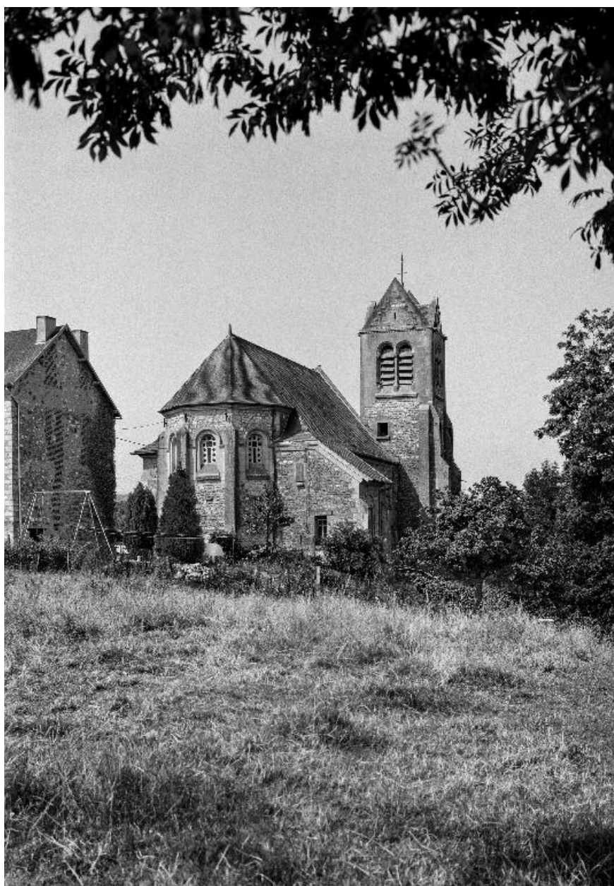
Vue d'ensemble de l'édifice depuis le nord-est.
